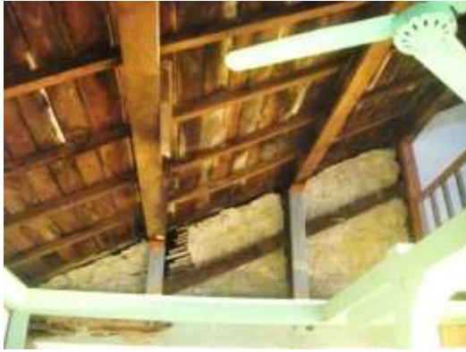
圖 38 裸露的竹編夾泥牆
