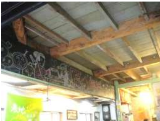
圖 27 一樓的天花板梁柱
