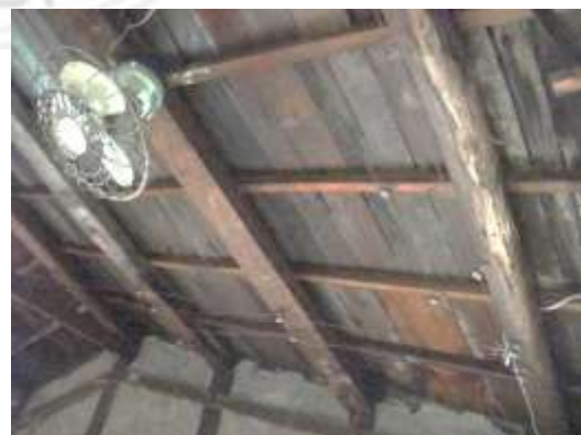
圖 43 舊式的配電方式
