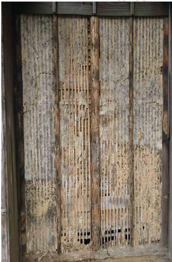
圖 4-2 雨淋板拆除後
