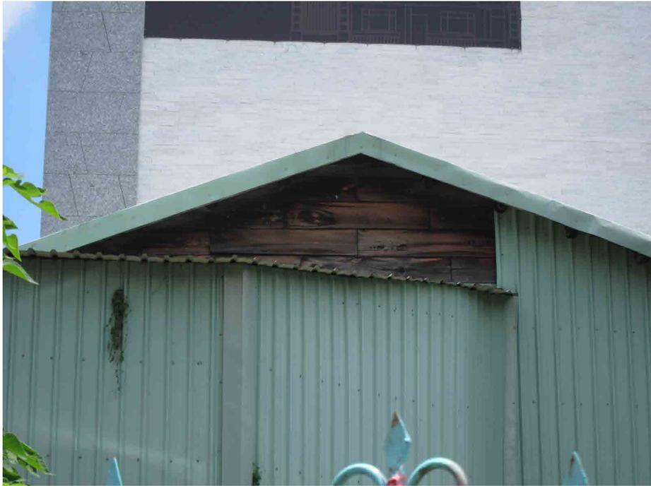
圖 1-15 後製雨淋板修改前
