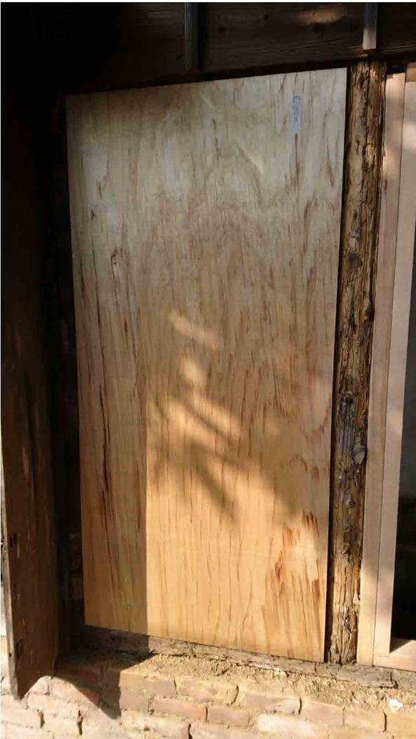
圖 4-4 結構合板安裝於框組上
