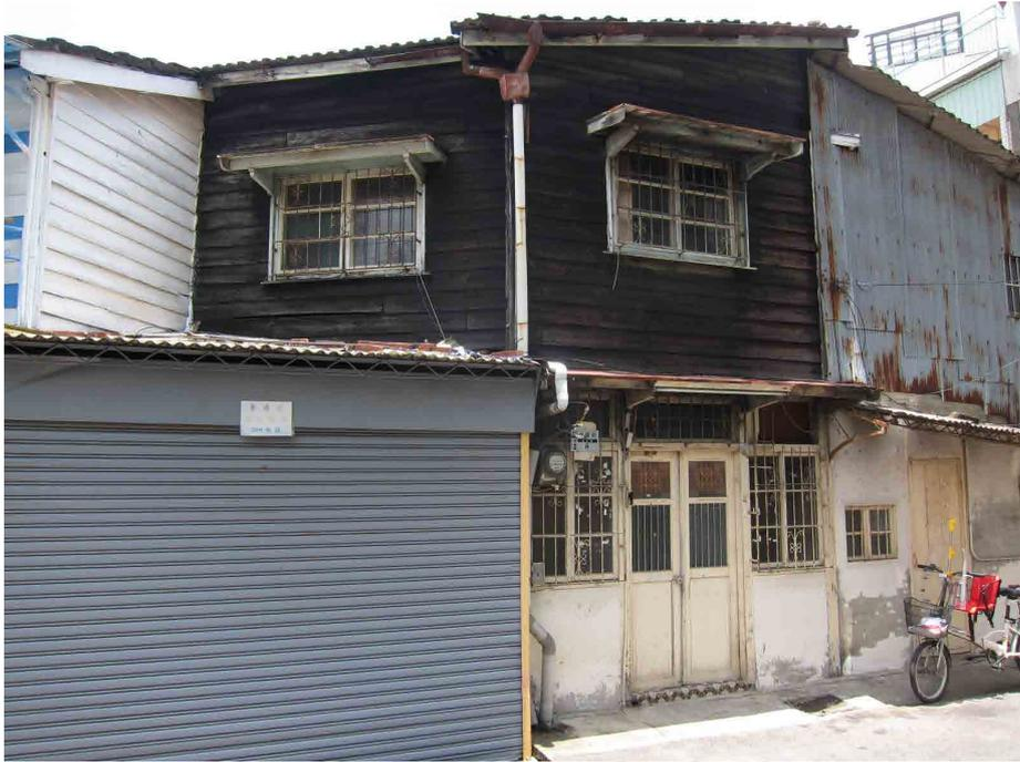
圖 1-17 後製雨淋板修改前
