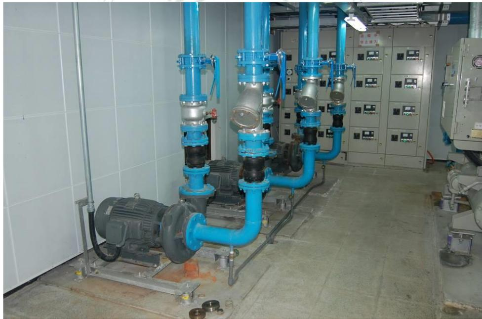
圖 20 冷卻水泵
