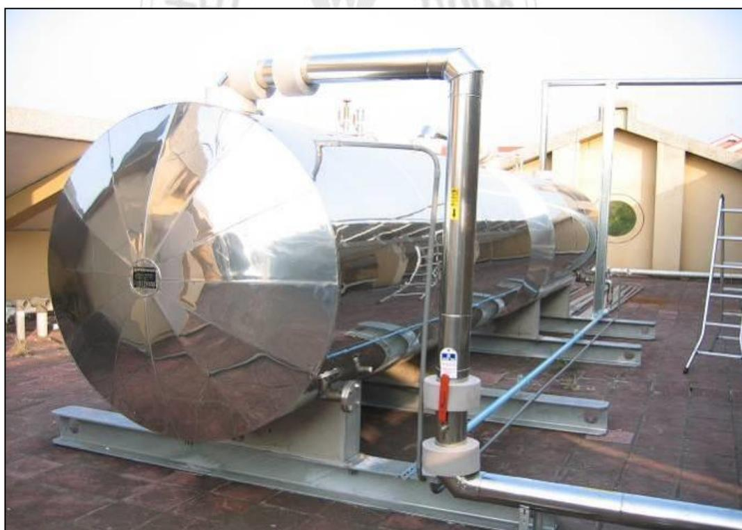
圖 41 太陽能熱水器集熱保溫桶
