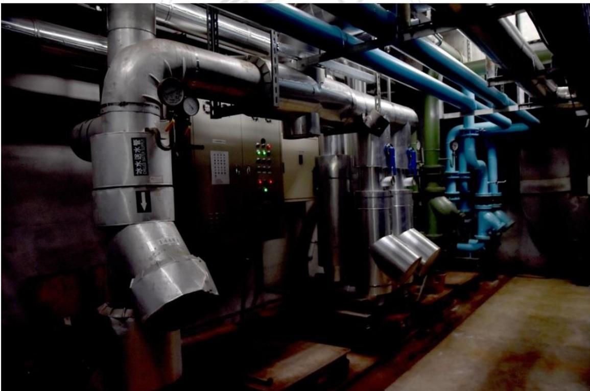
圖 13 冰水水泵、冷卻水泵及變頻器
