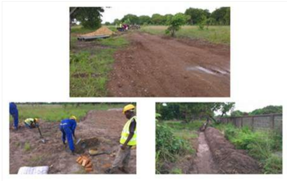
圖 4-8-6 區外截水及排水管溝施作 資料來源：本研究拍攝
