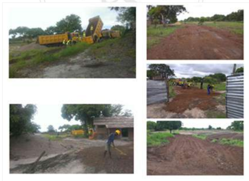
圖 4-8-5 區內、外施工便道鋪築 資料來源：本研究拍攝
