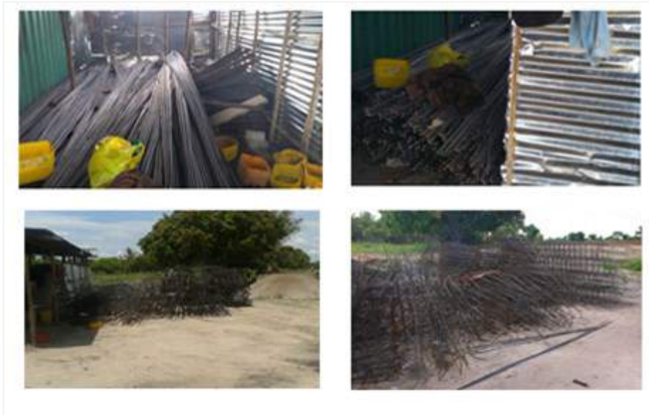
圖 4-8-2 建築材料陸續進場-鋼筋儲存及基礎鋼筋加工與組立 資料來源：本研究拍攝
