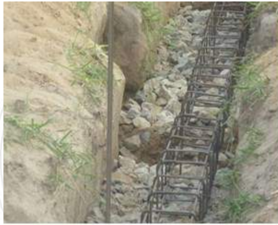
圖 4-7-11 堆放約 8CM*8CM 的石頭墊底後，放置預先綁砸成型的鋼筋籠
