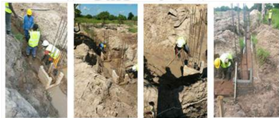
圖 4-8-13 因應雨季的工法-1.設導水溝及沉沙滯洪池 資料來源：本研究拍攝
