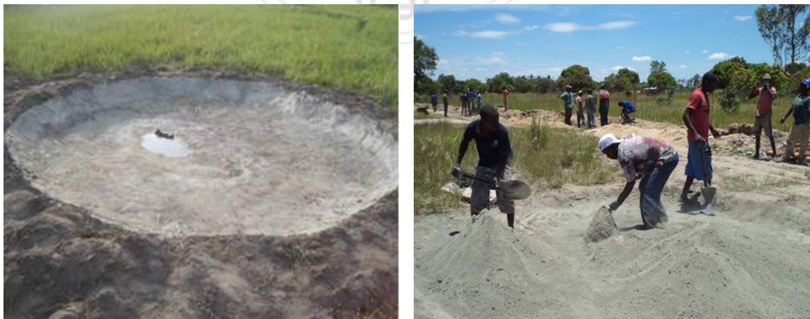
圖 4-7-12 弧形凹型拌合場及混凝土人工拌合方式
