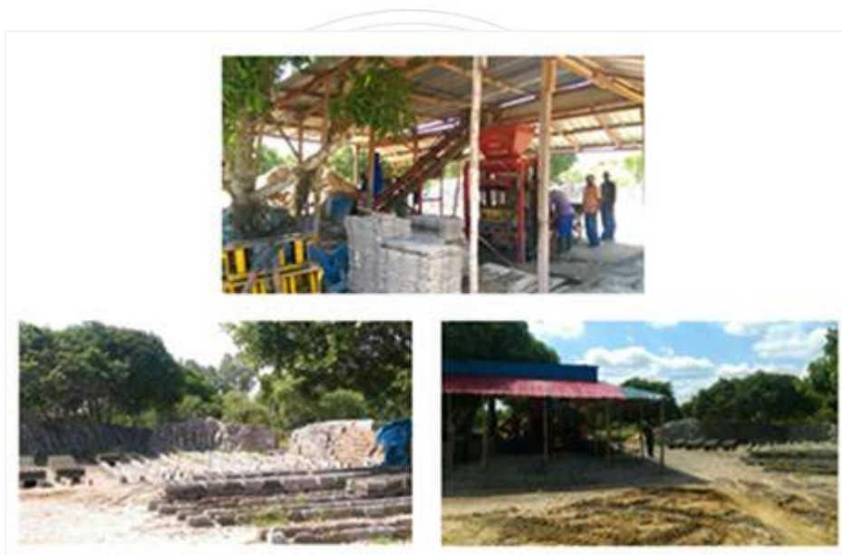
圖 4-8-8 自動製磚機場地施作-嚴格控管製磚品質 資料來源：本研究拍攝
