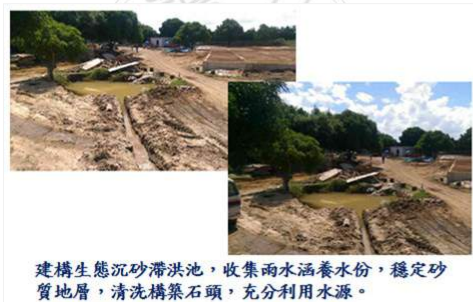
圖 4-8-16 生態沉砂滯洪池 資料來源：本研究拍攝
