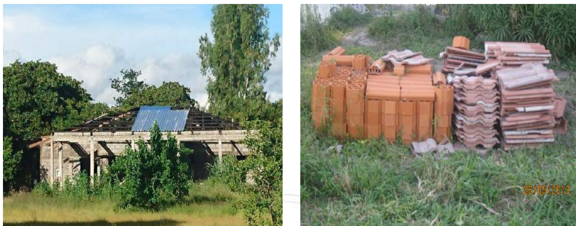
圖 2-4-16 屋頂施工及文化瓦 資料來源：本研究拍攝
