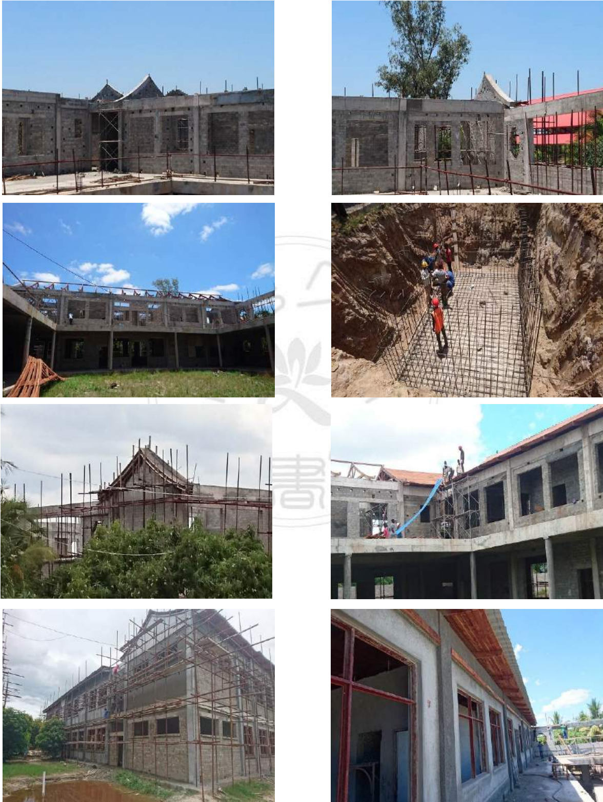
圖 4-8-19 兒童村各項工程施工過程 資料來源：本研究拍攝
