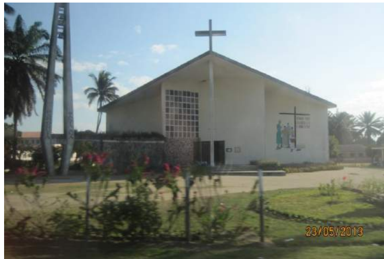
圖 2-4-7 葡萄牙殖民時期建築 公共建築政府機構、醫院及教堂 資料來源：本研究拍攝
