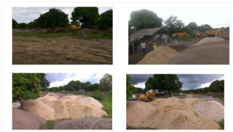
圖 4-8-3 建築材料陸續進場-石頭、沙、水泥、碎石級配 資料來源：本研究拍攝
