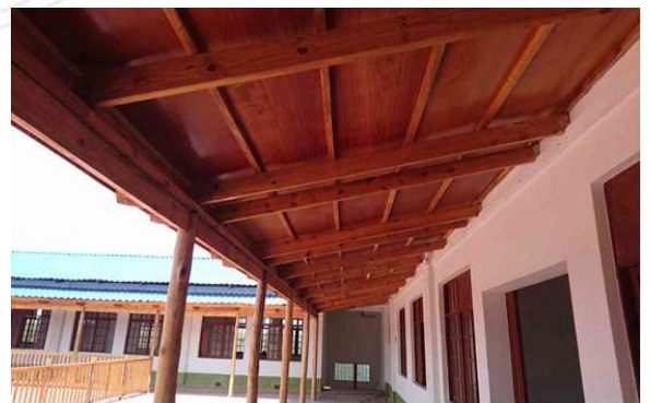
圖 3-3-19 兒童村二樓屋頂桁架 資料來源：本研究拍攝
