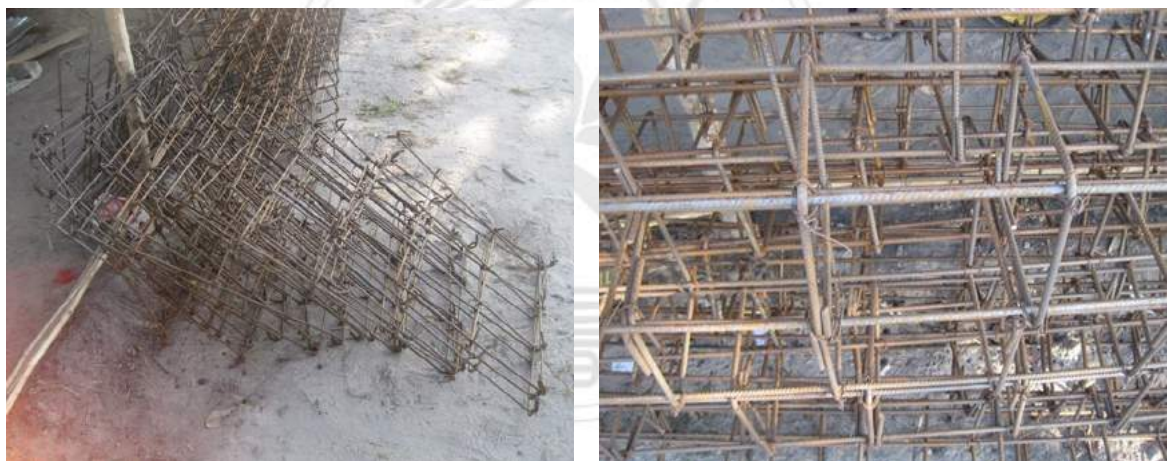
圖 4-7-9 鋼筋裁剪彎紮及綁紮施作 資料來源：本研究拍攝
