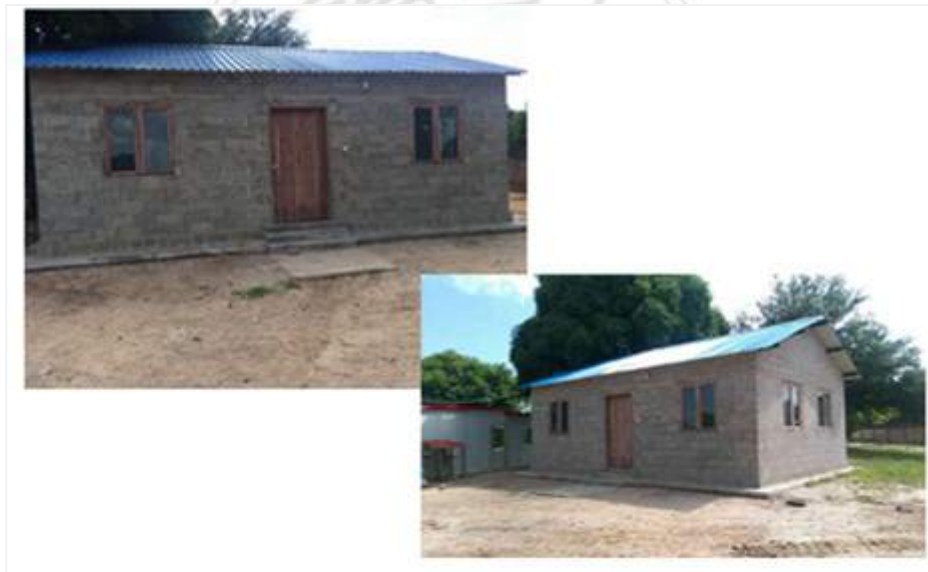
圖 4-8-18 臨時水、電工程-機房 資料來源：本研究拍攝
