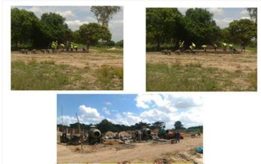
圖 4-8-4 混凝土拌合機及施工平台施作 資料來源：本研究拍攝
