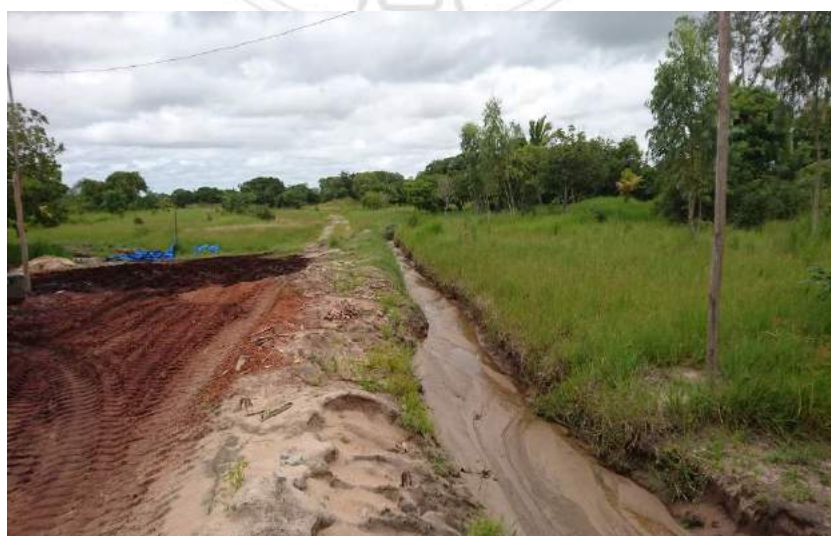
圖 4-2-1 園區外施作截水溝及草溝 資料來源：本研究拍攝
