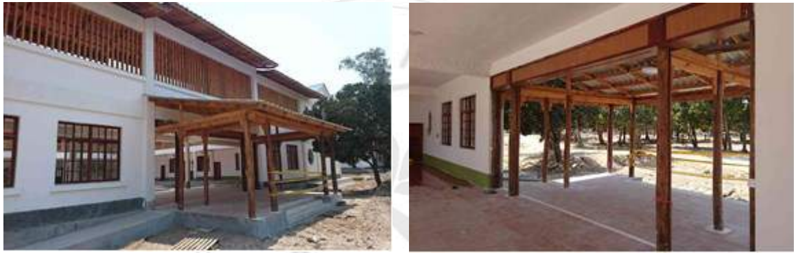
圖 3-3-11 兒童村大門施工中 資料來源：本研究拍攝
