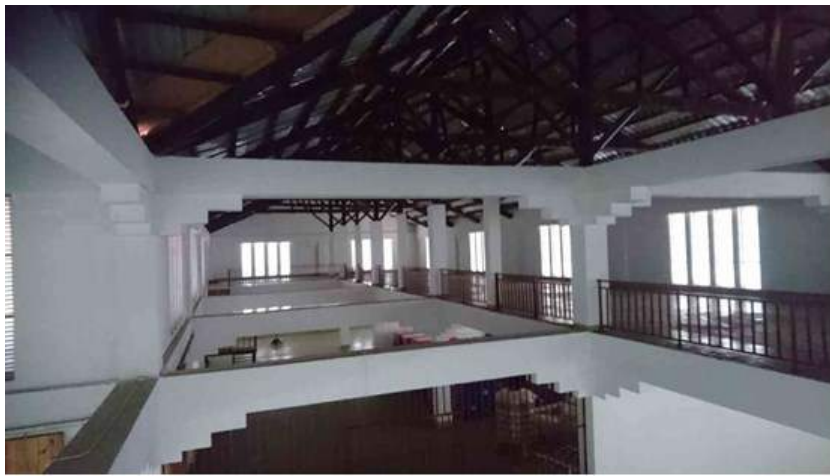
圖 3-3-34 倉庫樑柱系統 資料來源：本研究拍攝
