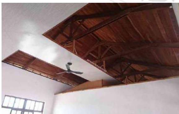
圖 3-3-19 兒童村二樓屋頂桁架 資料來源：本研究拍攝
