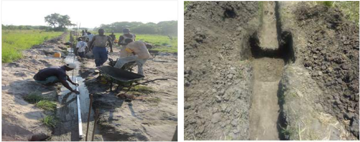
圖 4-7-10 地樑放樣、開挖及場拌混凝土澆置施作
