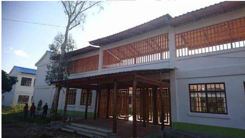
圖 3-3-12 兒童村大門施工完成 資料來源：本研究拍攝
