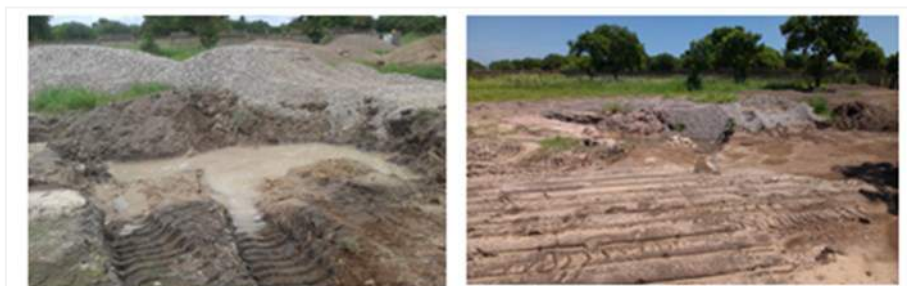
圖 4-8-14 因應雨季的工法-2.以固化劑改良地質 資料來源：本研究拍攝
