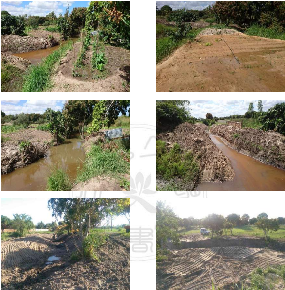
圖 4-8-25 河道整治施工過程 資料來源：本研究拍攝
