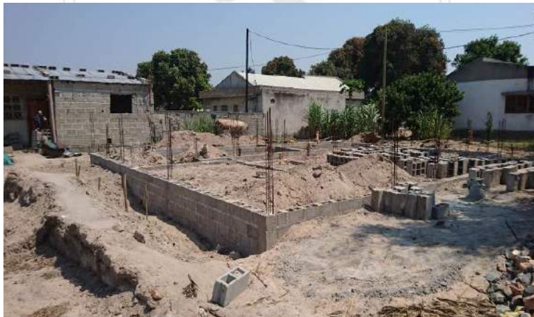
圖 2-4-13 地樑與柱基礎施工 資料來源：本研究拍攝
