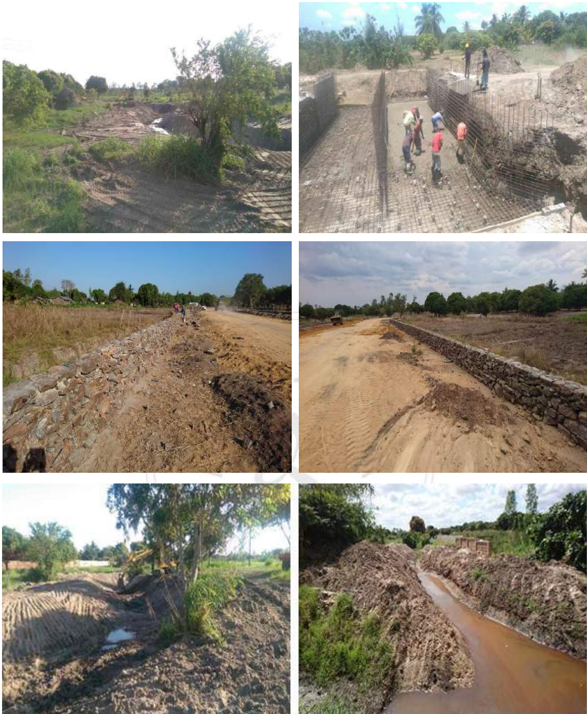
圖 4-2-2 聯外道路施工 資料來源：本研究拍攝
