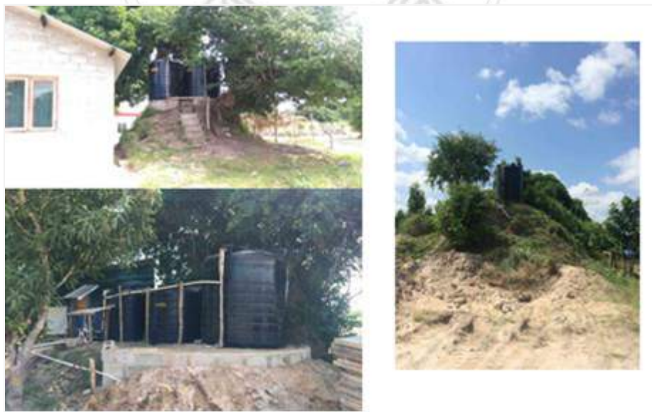
圖 4-8-11 臨時水、電工程-串聯的儲存供水 資料來源：本研究拍攝
