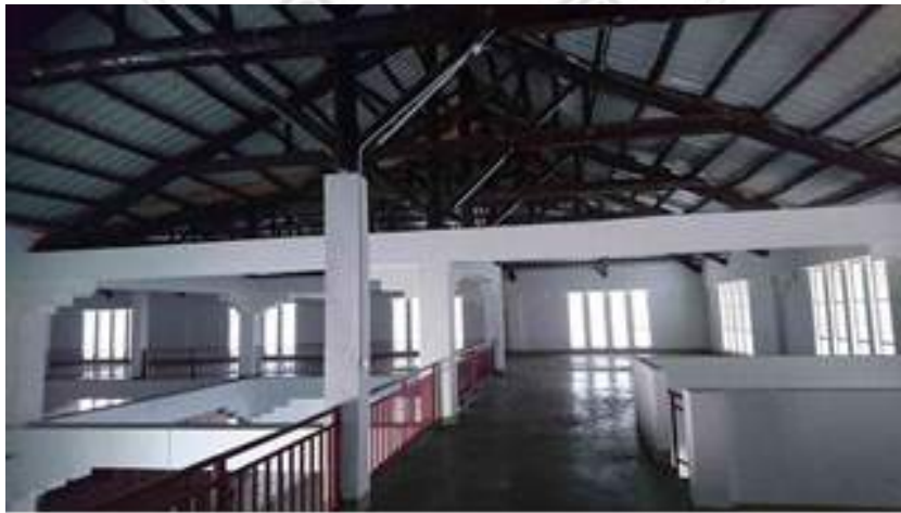
圖 3-3-35 倉庫屋頂桁架系統 資料來源：本研究拍攝
