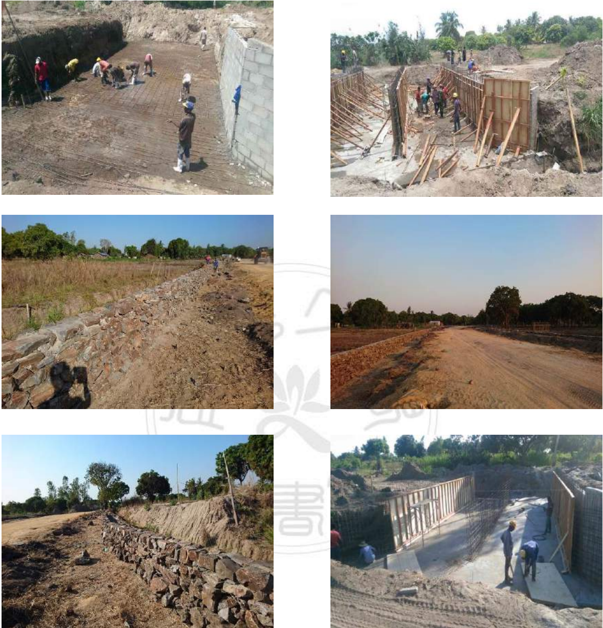
圖 4-8-24 聯外道路各項工程施工過程 資料來源：本研究拍攝
