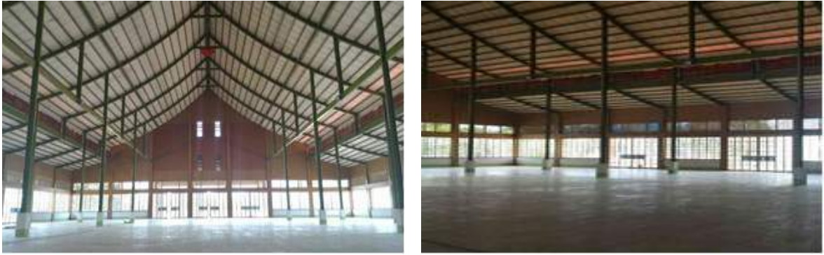
圖 3-3-49 中央餐廳屋頂桁架及樑柱系統 資料來源：本研究拍攝
