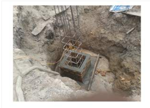
圖 4-8-15 因應雨季的工法-3.柱基礎以砌磚為模板並點井抽水 資料來源：本研究拍攝
