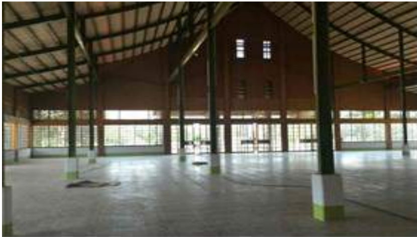
圖 3-3-50 中央餐廳屋頂桁架及樑柱系統 資料來源：本研究拍攝
