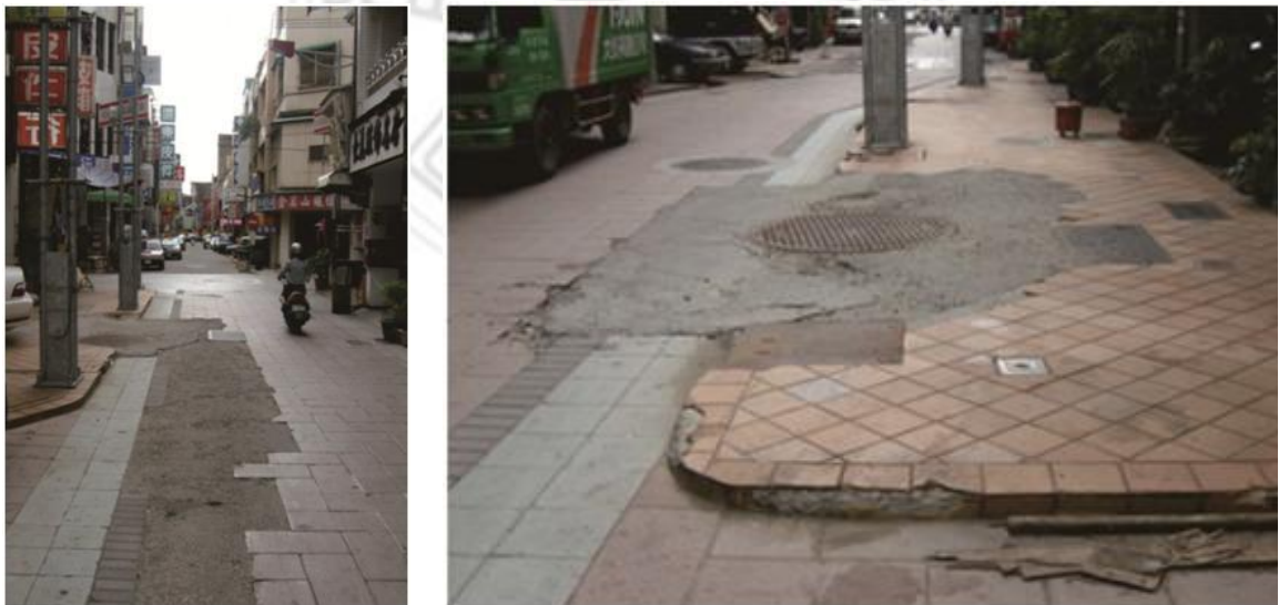
圖 15 二度施工造成的鋪面損毀
