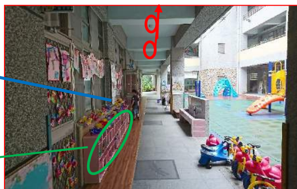
圖 4.2.7 幼兒園教室前方走廊及照明設備
