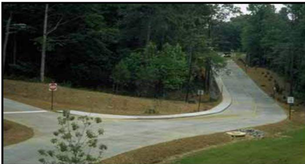
圖 2.2 混凝土鋪面應用於次要道路 資料來源：Ghafoori, N. and S. Dutta, (1995)
