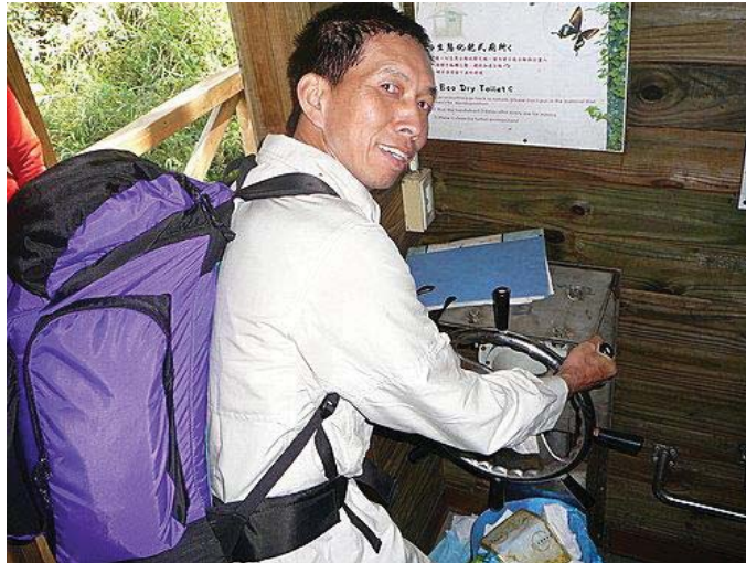
圖 4.16 使用完畢，要同一方向轉動手輪 資料來源：雪山 369 山莊生態廁所研習（陳國帝）
