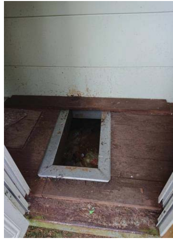
圖 4.25 雪北山屋廁所內部
