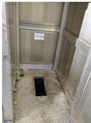
圖 4.29 南湖山屋廁所內部
