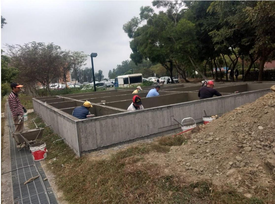
圖 4-7 表面以水泥砂漿 1:3 粉刷保護防水層
