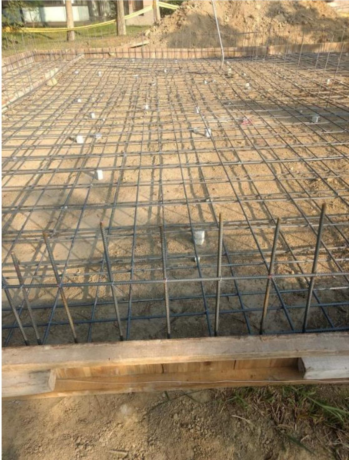
圖 4-4 鋼筋鋪設綁紮與板模組立
