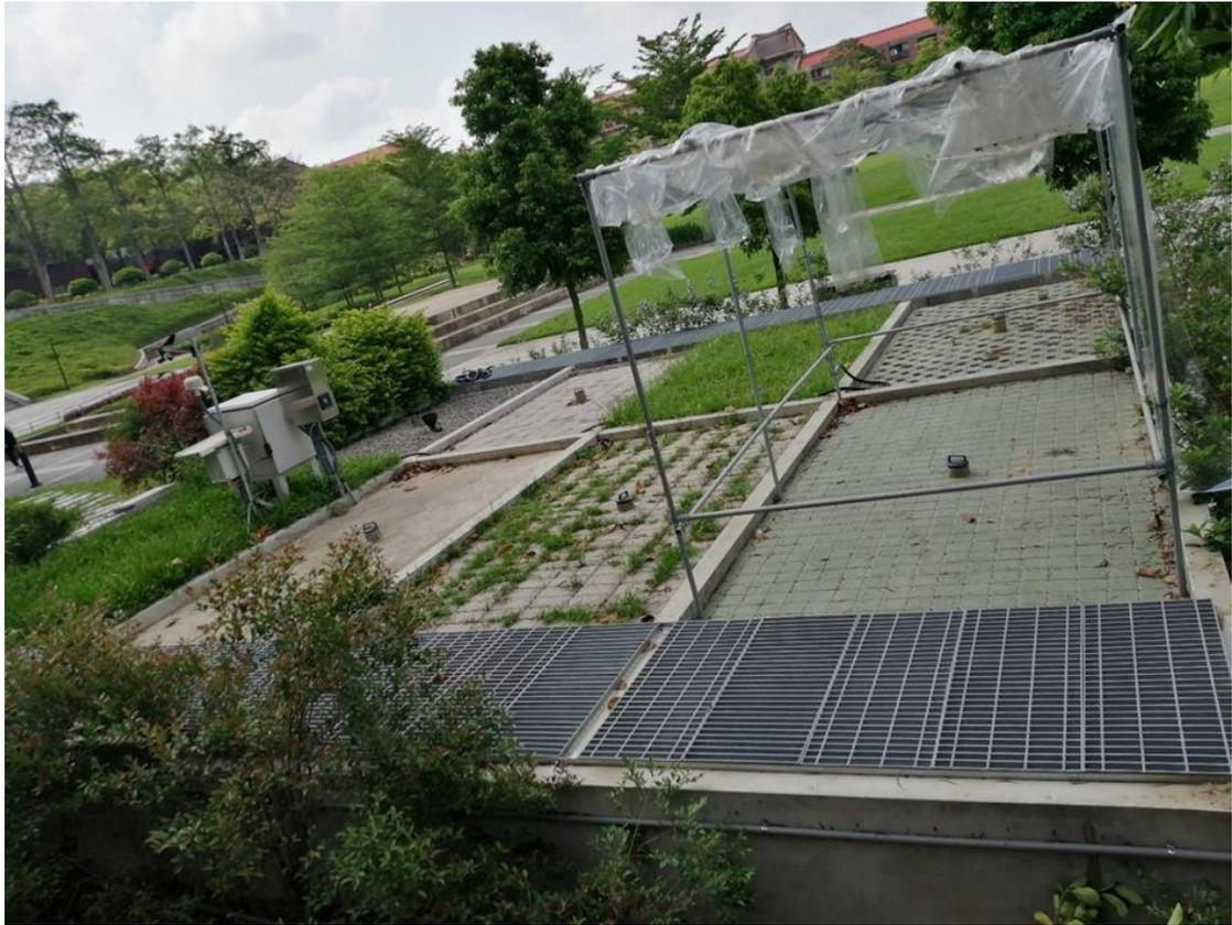
圖 4-8 場域透水鋪面完成鋪設
