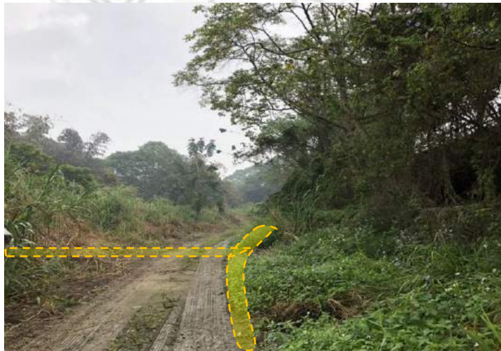
草溝、涵管及沉砂滯洪池施作地點現況照片
