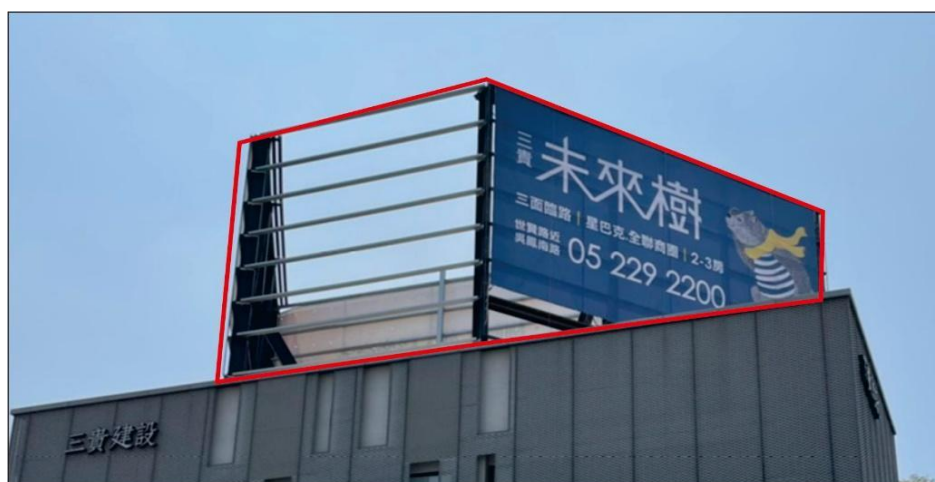
樓頂上所搭設的鐵架
