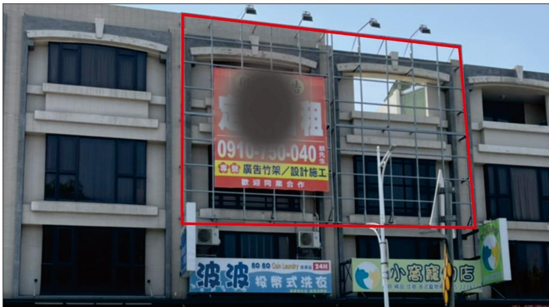
向樓主租賃廣告商搭建的鐵架
