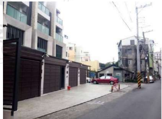
照片5-6：公園路736巷新建豪宅
