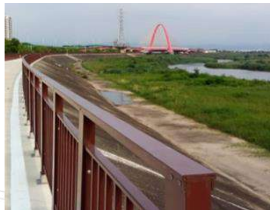
照片4-6：環河路口三段臨溪護岸 資料來源：本研究自行拍攝
