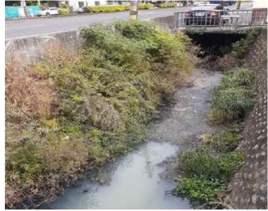
照片5-12：新興路臨廣惠二巷溝渠 資料來源：本研究自行拍攝
