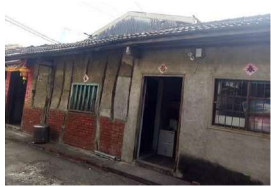
照片4-4：水災後重建編竹夾泥牆屋 資料來源：本研究自行拍攝
