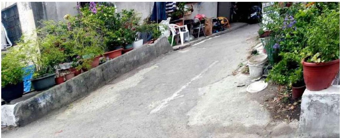
照片 5- 54：後背溝臨新興路廣惠三巷 6 弄橋面護欄現況
