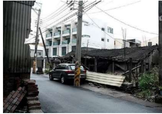
照片4-14：新舊建築雜處-公園路736巷 資料來源：本研究自行拍攝
