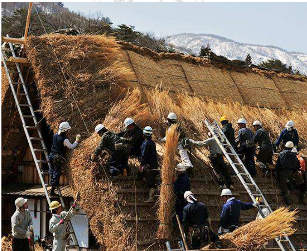
圖3- 22：白川村合掌造更換老朽的屋頂茅草
