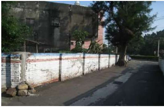
照片 5- 35：公園路 552 巷圍牆改造前 資料來源：湖日社區提供
