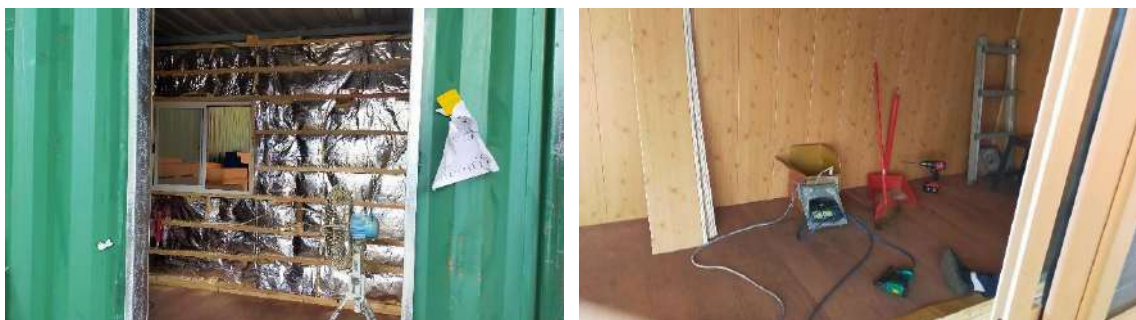
圖 4-29 貨櫃內部隔熱與裝潢工作
