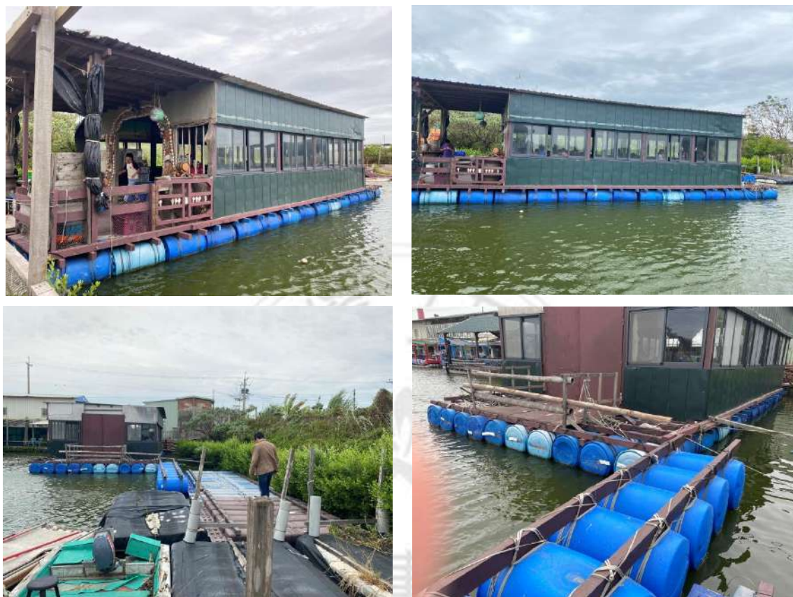
圖 4-33 向禾休閒魚場浮屋基座工法
