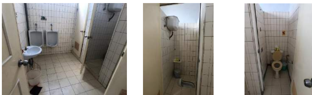
圖 66 排路里活動中心內廁所使用現況
