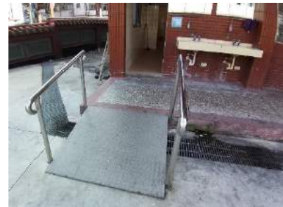
圖 64 無障礙坡道及扶手之設置
