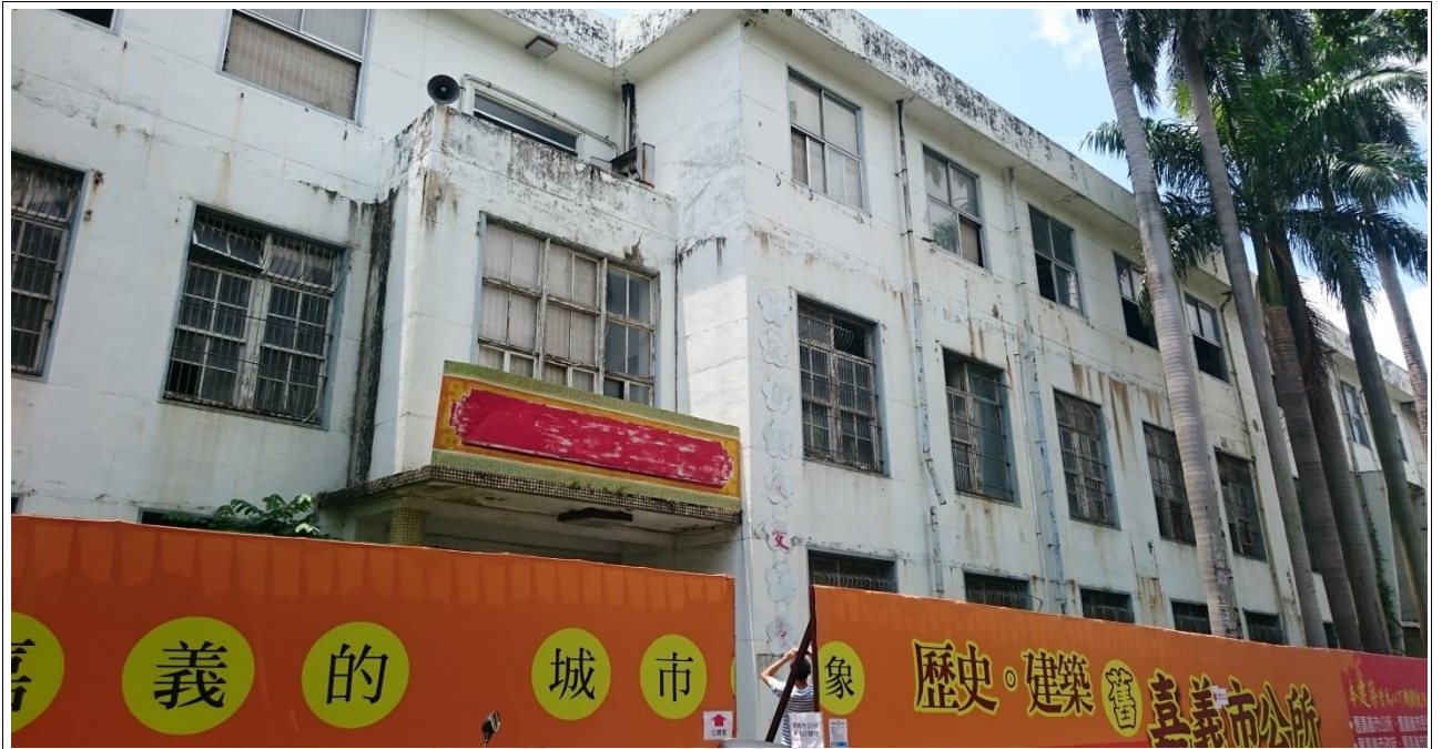
東南側市公所入口側面
