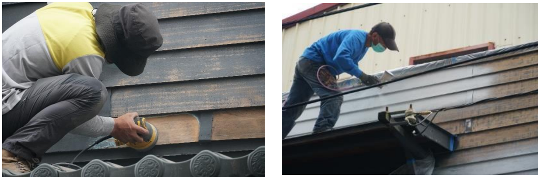
圖 71 雨淋板去漆與重新上漆
