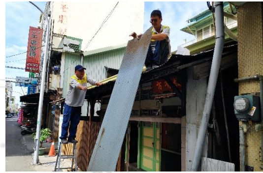
A 側雨遮鐵皮拆除
