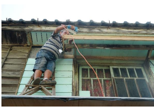
蘭井街 81 號二樓雨遮鋪設面板
