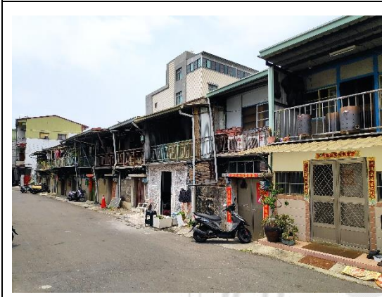
方興路 17 巷建物外觀紀錄
