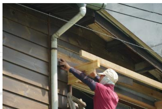
C 側後半邊雨遮新作
