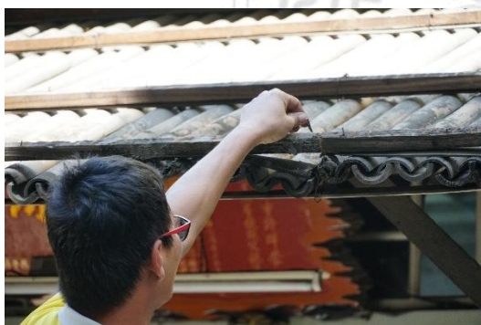
A 側雨遮舊壓條拆除
