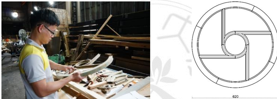
圖 76 窗戶拆解尺寸紀錄與圖面繪製
