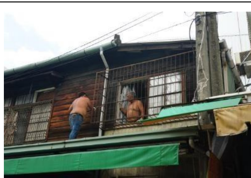
外凸鐵窗拆除
