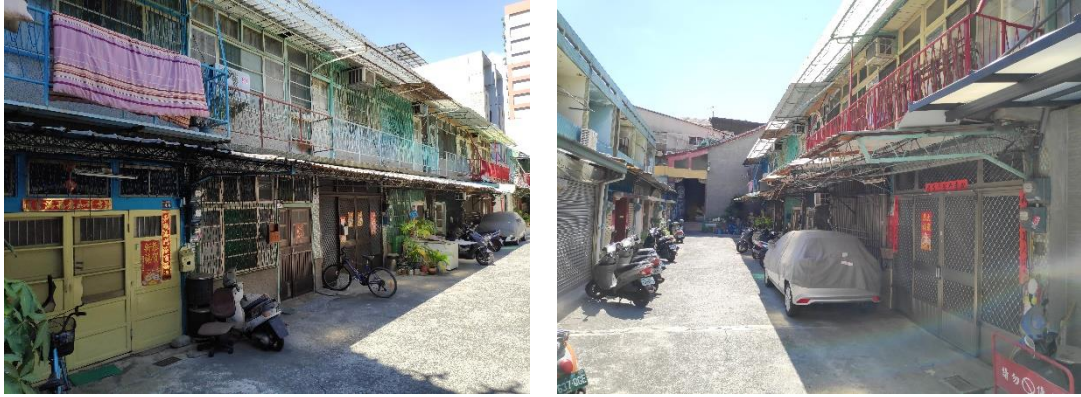
圖 64 二層樓式，一樓無圍牆之建築類型現況照
