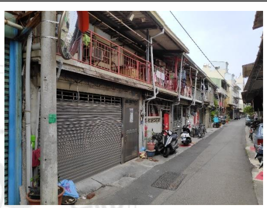
彌陀路建物外觀紀錄
