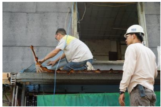
忠孝路 32 號一樓雨遮鐵皮拆除
