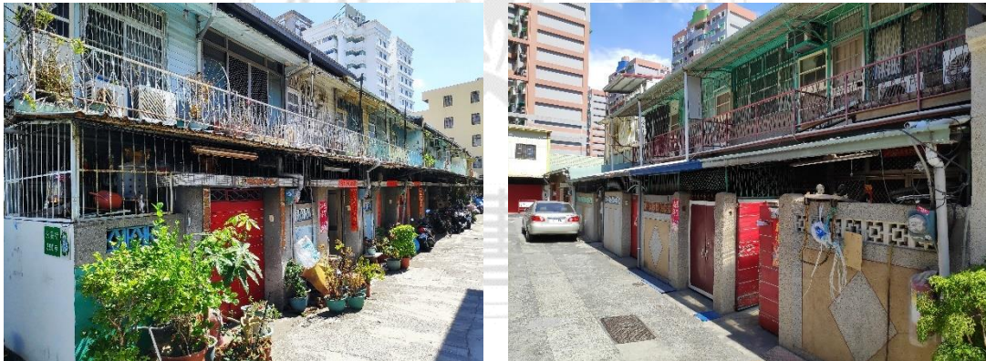
圖 63 二層樓式，一樓有圍牆之建築類型現況照
