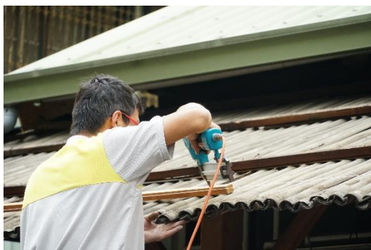
A 側雨遮舊壓條拆除
