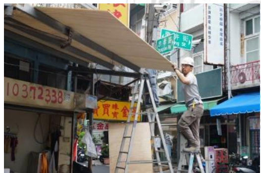
忠孝路 32 號一樓雨遮鋪設結構合板
