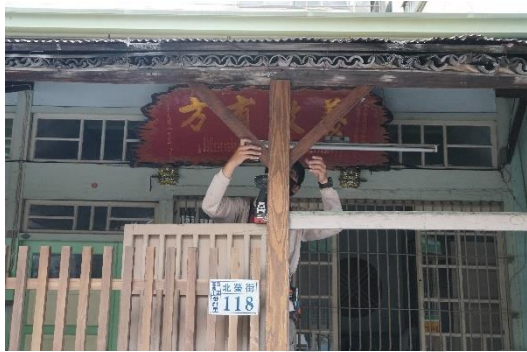
A 側柱體斜撐裝設
