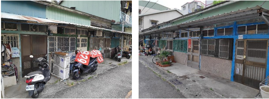
圖 62 一層樓式，外圍無圍牆之建築類型現況照
