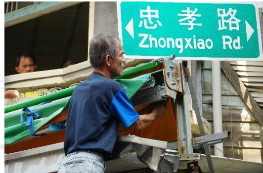
忠孝路 32 號一樓活動雨遮拆除換位
