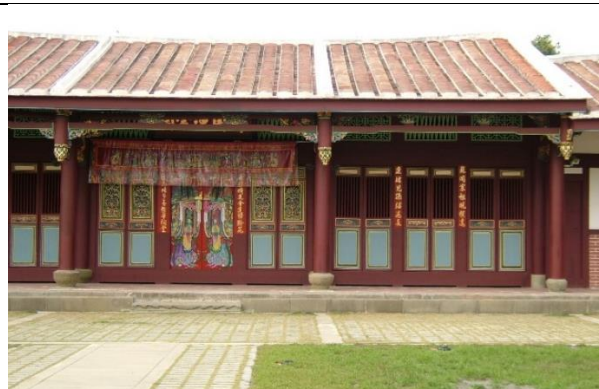
施作完成後蘇周連宗祠正面
