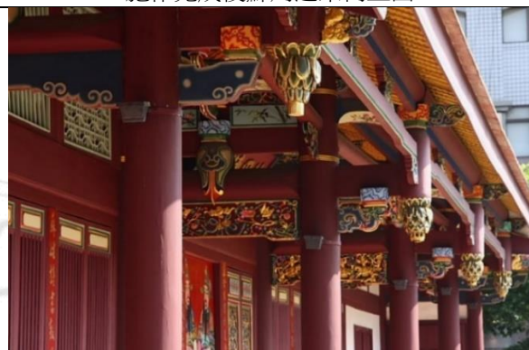
施作完成後蘇周連宗祠外面木構架
