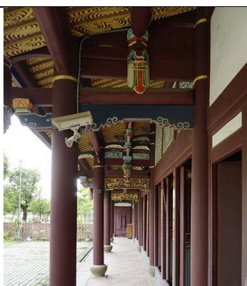
施作完成後走廊木構架彩繪
