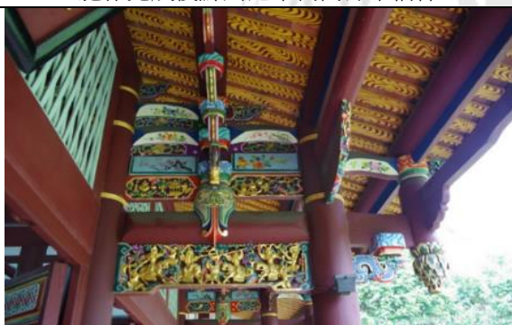
施作完成後蘇周連宗祠木構架彩繪
