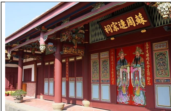
施作完成後蘇周連宗祠正面
