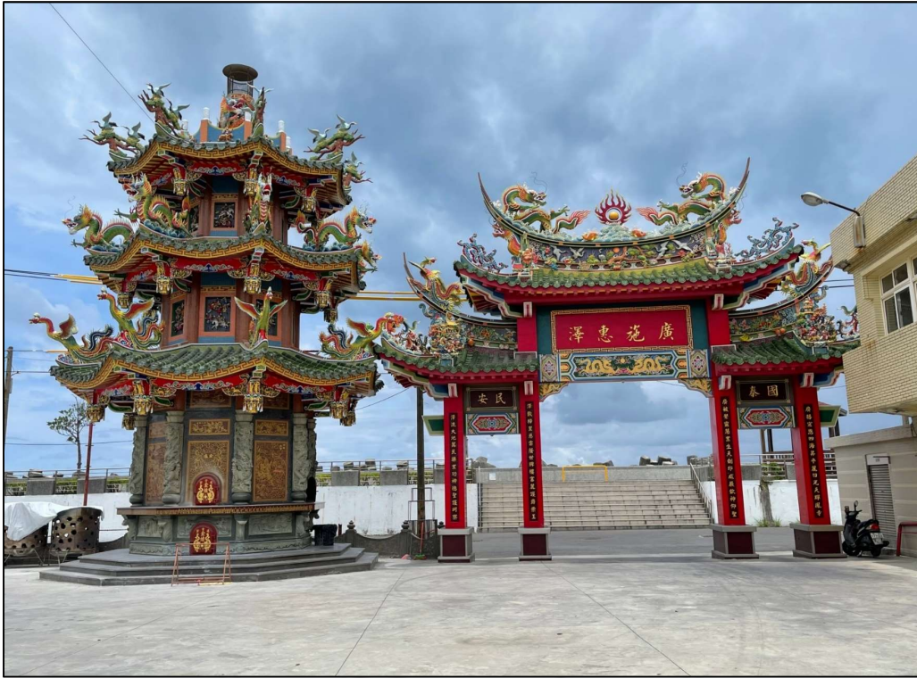
圖 49：通安宮側牌樓
