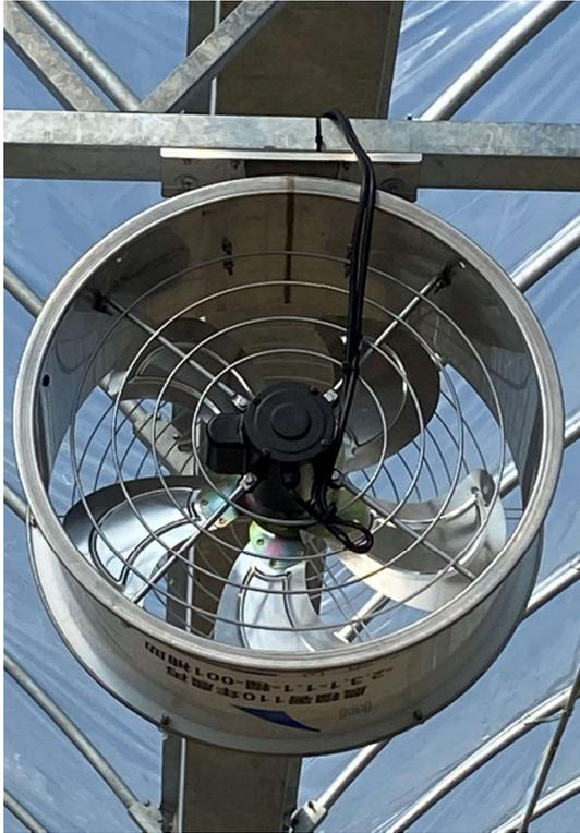
說明：溫室內建 CO2 感應偵測器，設定大於或小於 PPM 或時間設定適當開啟運作，讓室內含氧量及含碳量中和。(一般正常室外約 400-500PPM、室內超過 800PPM 就偏高、超過 1000PPM 需啟動循環風扇，以利植物光合作用生長)
