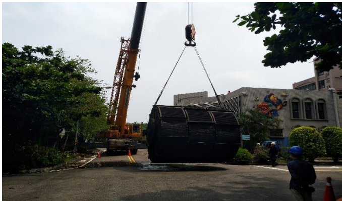
圖 4-1 生物旋轉圓盤更新工程
