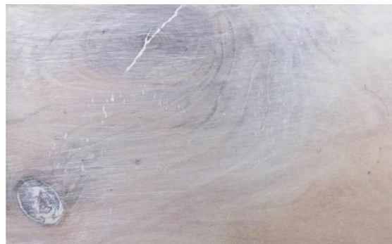
補土施工完成
