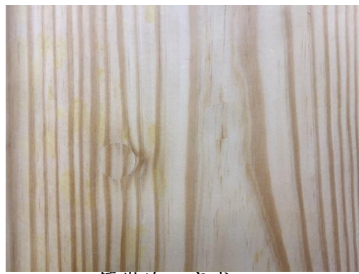
鑲嵌施工完成
