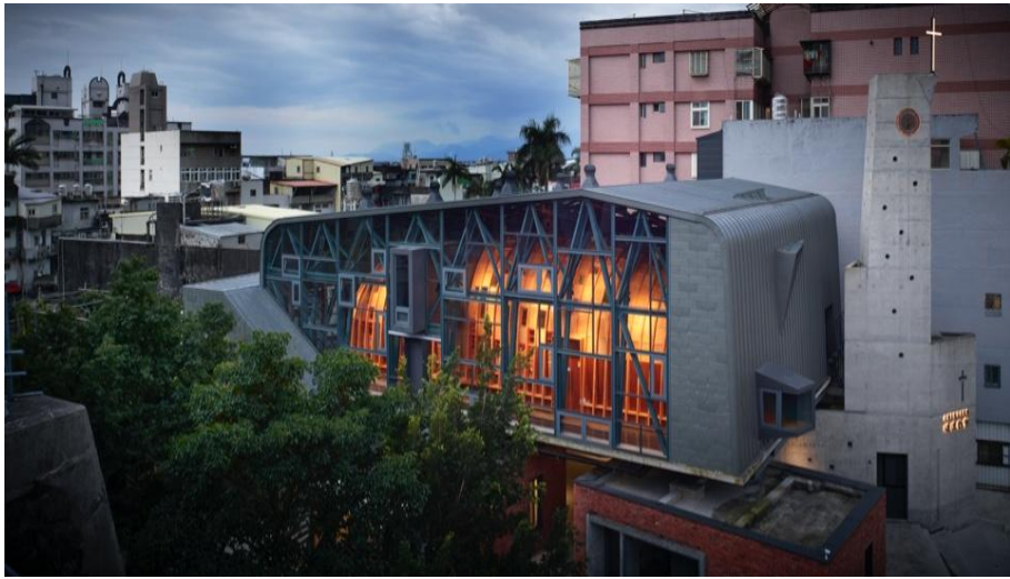
圖 5-7 礁溪長老教會會堂架高於房角石上(資料來源:立聯合建築師事務所)
