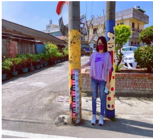
(電線桿水位警戒線，高度 100)
