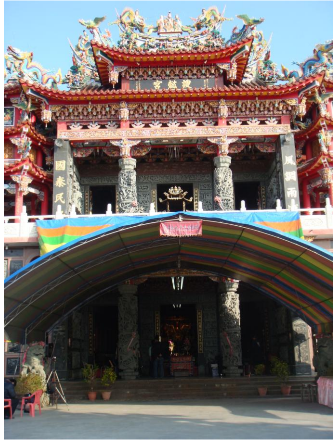
附錄圖 2-29 彰化縣永靖鄉謏懿宮全景圖。(藍郁琇拍攝)
