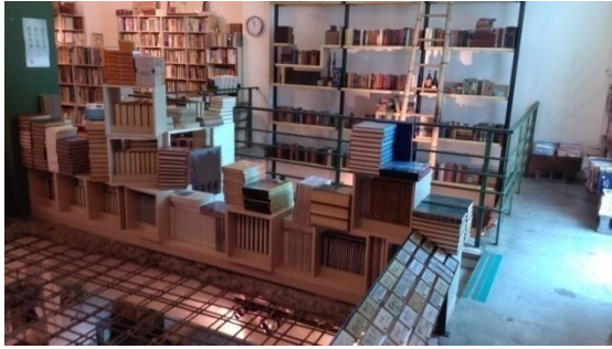
圖 16 「草祭」破開樓板創造新的空間動線
