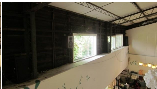
圖 19 「隨光呼吸」室內空間 2
