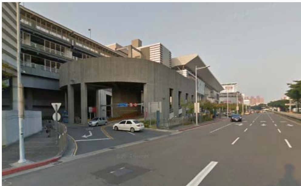
照 4-2 繁榮的左營高鐵站
