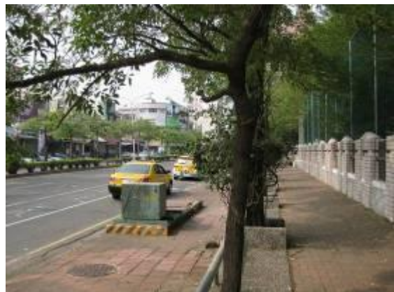
八德路圍牆現況
