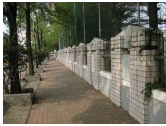
八德路圍牆樣式
