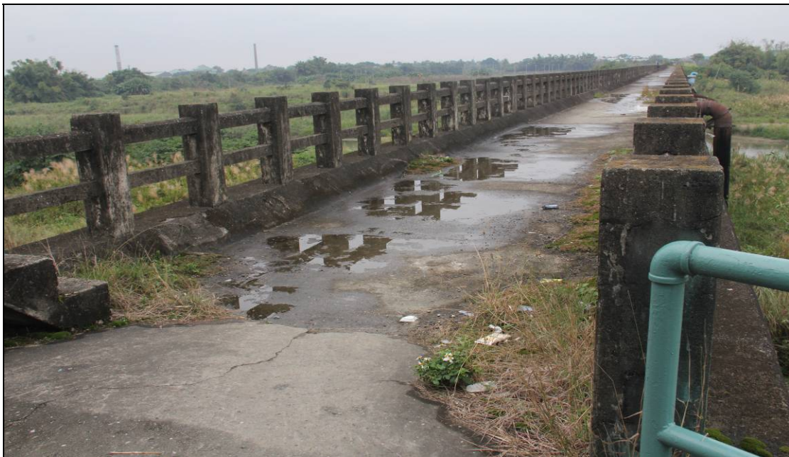
照片六：近觀水橋（上面是橋，下面是水道）
