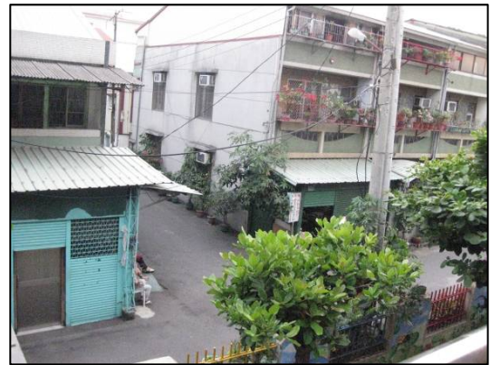
圖 4-12 鄰里建物多為連棟二層加蓋鐵皮屋 資料來源：本研究拍攝
