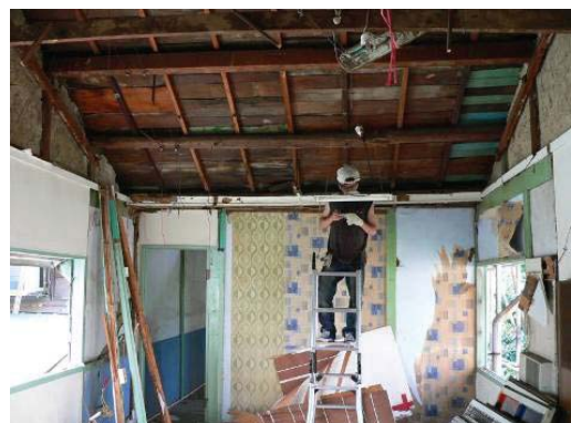
圖 4-2-3 玉山旅社外、內部修復中結構受損情形（圖片提供：嘉義市洪雅文化協會） 使用傳統材料及相關技術修復屋頂及漏水部份。
