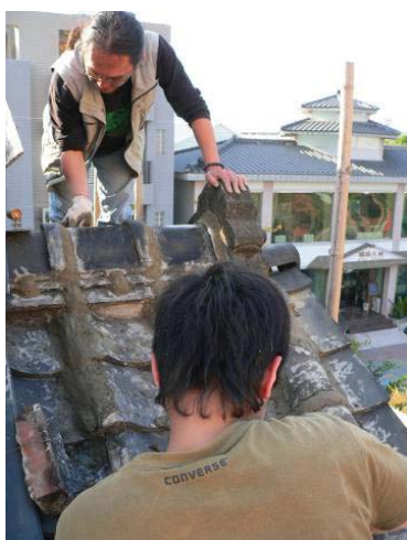
圖 4-2-3 玉山旅社外、內部修復中結構受損情形（圖片提供：嘉義市洪雅文化協會） 使用傳統材料及相關技術修復屋頂及漏水部份。
