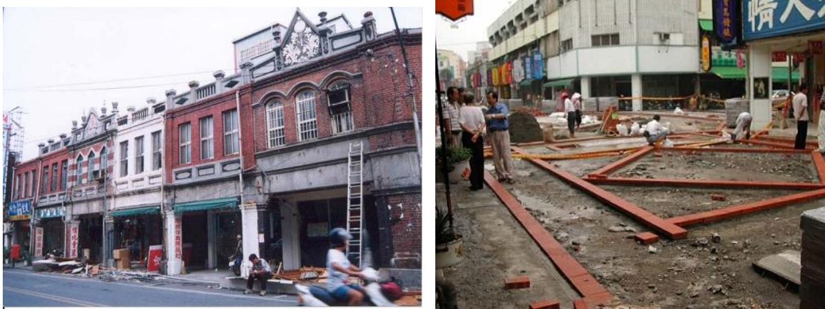
圖4-7 太平老街再造計畫的施工過程
