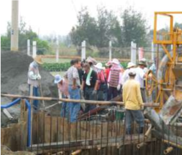
圖 3.2.2-11 有工程進行，團長皆現場指導（本研究拍攝 2011.10）
