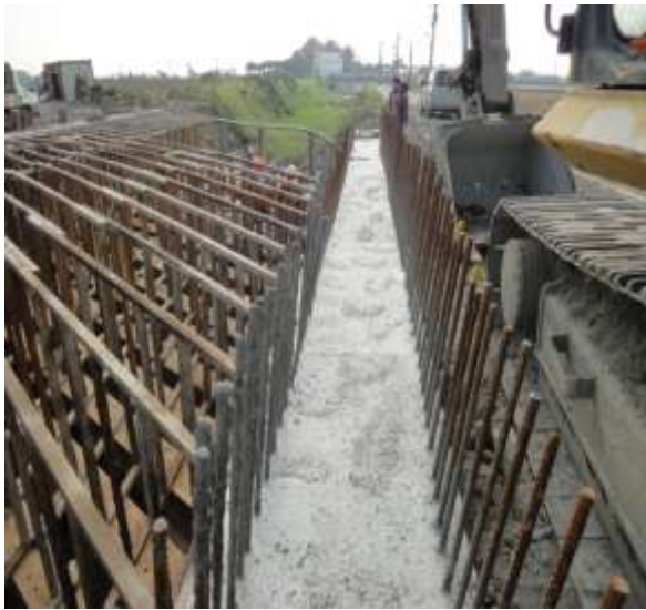
圖 3.2.2-16 涵箱橋邊墩與橋面版模架設 (本研究拍攝 2012. 01)
