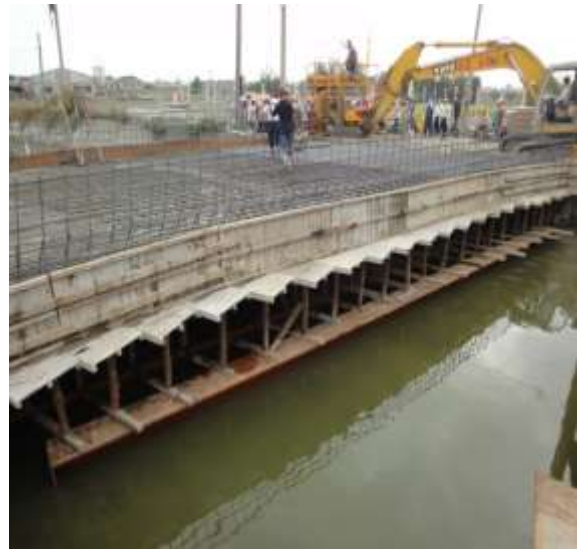
圖 3.2.2-17 涵箱型拱橋橋面施作 (本研究拍攝 2011. 11)
