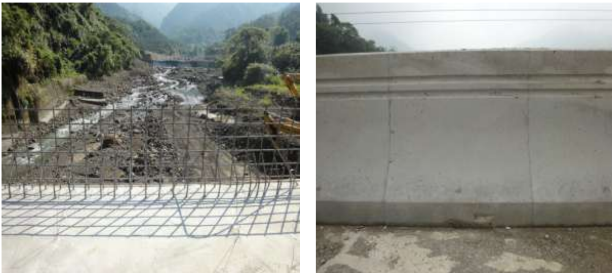
圖 3.2.1-9 紐澤西護欄 (Jersey barrier) 做安全防護
