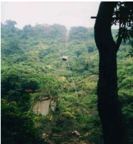
圖 3.1.3-1 利用「流籠」運送混凝土設備等 (嘉邑行善團提供)
