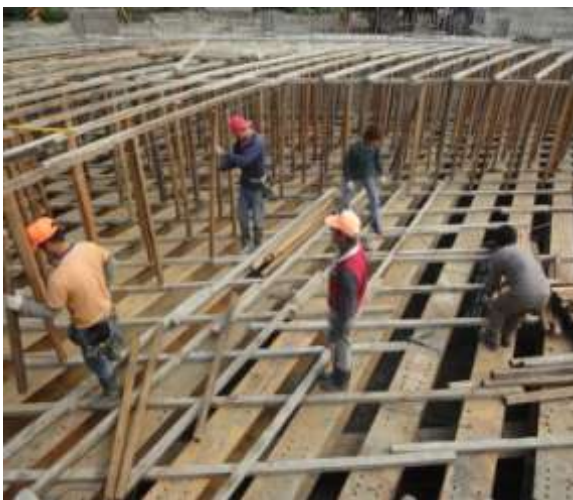
圖 3.2.2-20 板模技術人員沿線搭起橋面支架(仁勸橋施作現場) (本研究拍攝 2012.01)
