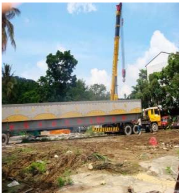
圖 3.2.1-3 高雄市仁煌人行陸橋 施工過程 (嘉邑行善團提供)
