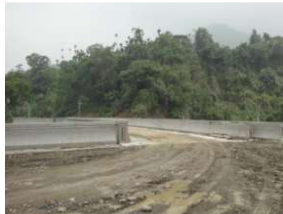
圖 3.2.2-29 橋邊引道填土鋪設 (本研究拍攝 2011.09)
