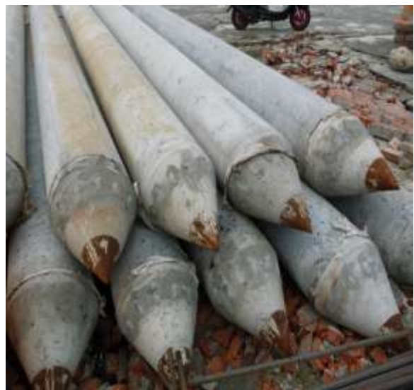
圖 3.2.1-11 嘉邑行善團預製樁（本研究於俊雄二號橋工地拍攝，2011.10）
