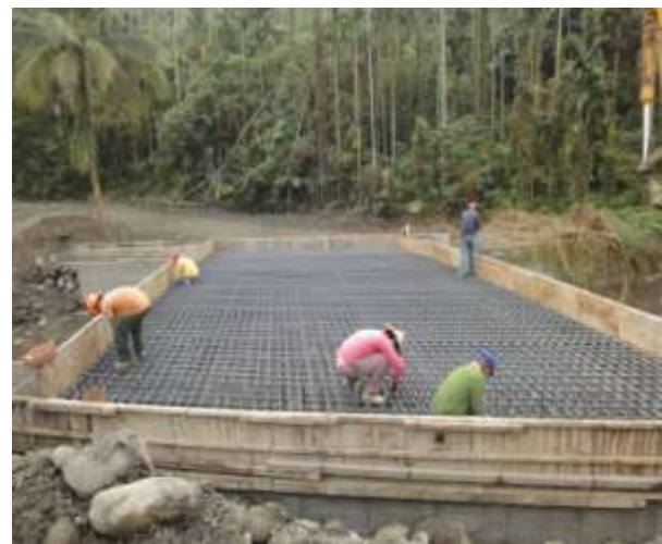
圖 3.2.2-21 拉一條水平線以固定上層鋼筋鋪設位置(仁道橋現場) (本研究拍攝 2012.01)
