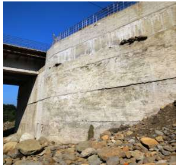
圖 3.2.2-18 大排溝渠橋梁邊墩與堤防結合 (本研究拍攝 2011.10) 圖 3.2.2-19 預力橋之橋邊墩基礎與擋土牆 (本研究拍攝 2011.07)
