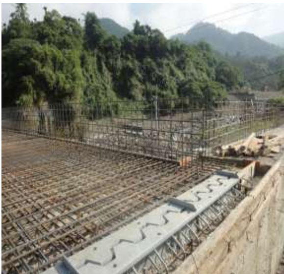
圖 3.2.2-23 伸縮縫鋪設 (本研究拍攝 2011.07)
