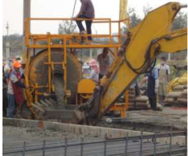
圖 3.2.2-26 挖土機挖杓反裝方便 輸送混凝土鋪設 (本研究拍攝 2011.07)
