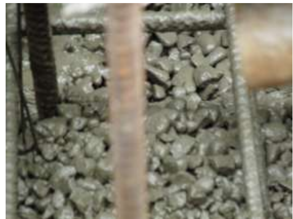
圖 3.2.2-14 爆米花時需調整混凝土與做適當處置(本研究拍攝 2011.10)
