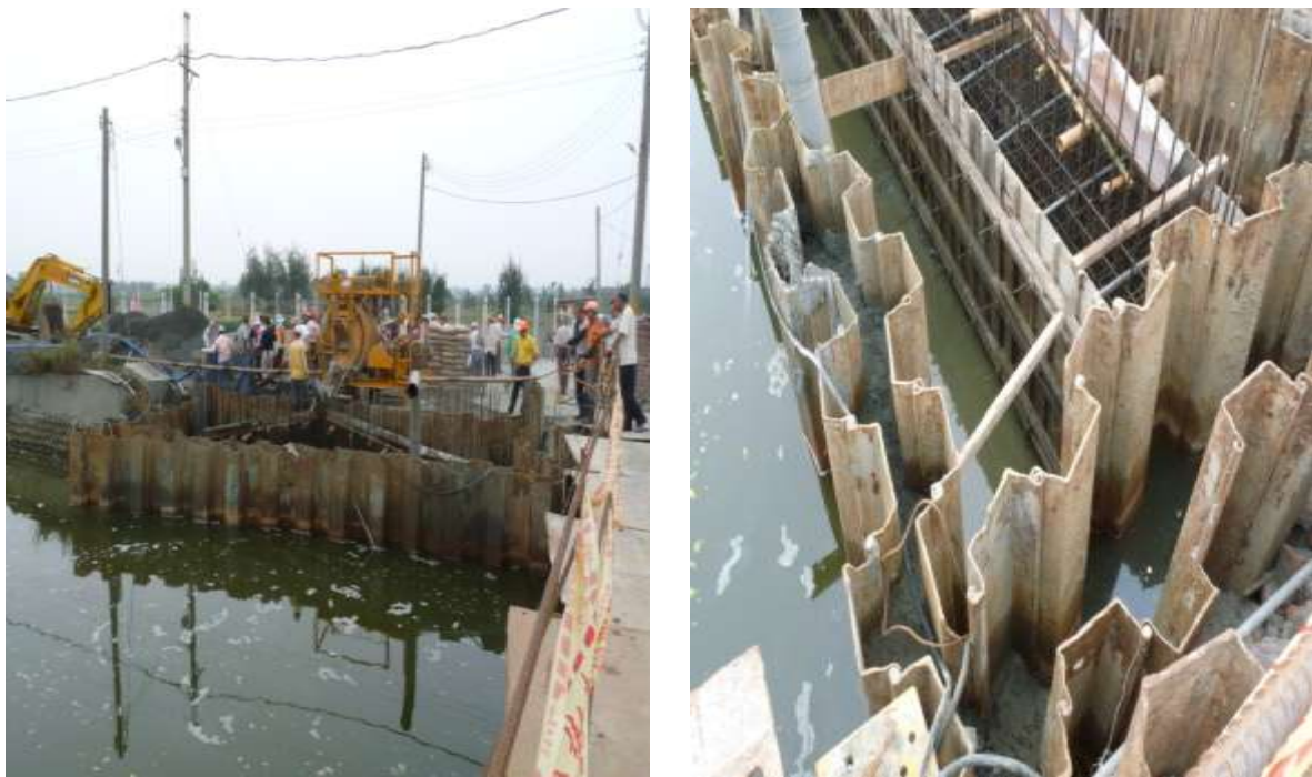
圖 3.2.2-15 海邊大排建橋時，隔水法讓基樁能順利施作
