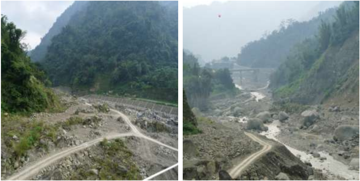
圖 4.2.2-2 土石流下的達那伊谷整治與完工的新山美大橋
