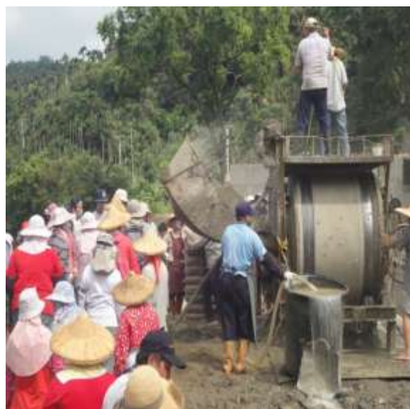
圖 3.2.2-8 混凝土攪拌機具 (本研究拍攝 2011.07)
