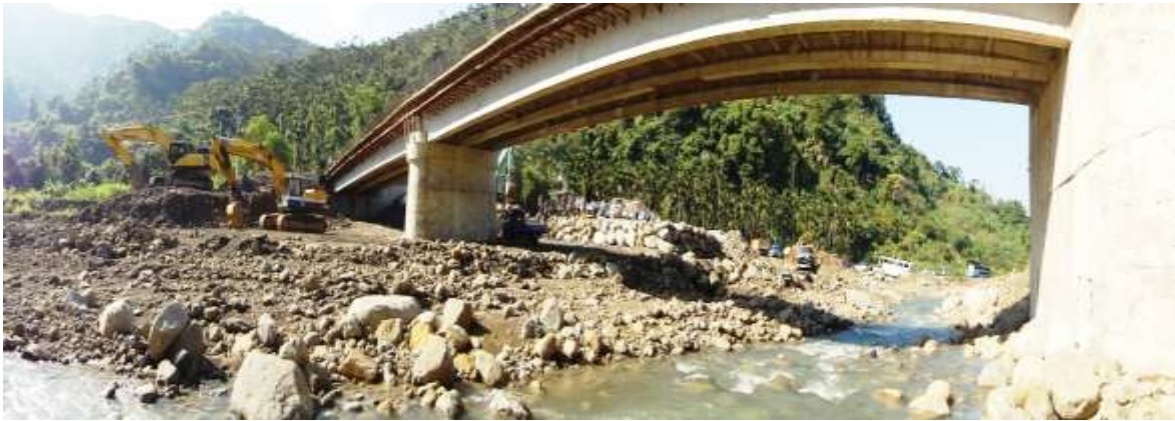
圖 3.2.2-32 嘉邑行善團建造 70 公尺仁裕橋的施作場地 (本研究拍攝 2011.07)
