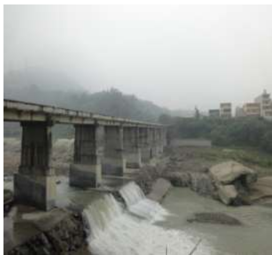
圖 3.3.1-2 嘉邑行善團進行修繕 工程已於 2009 年 12 月 25 日完工 (本研究拍攝，2011.10)
