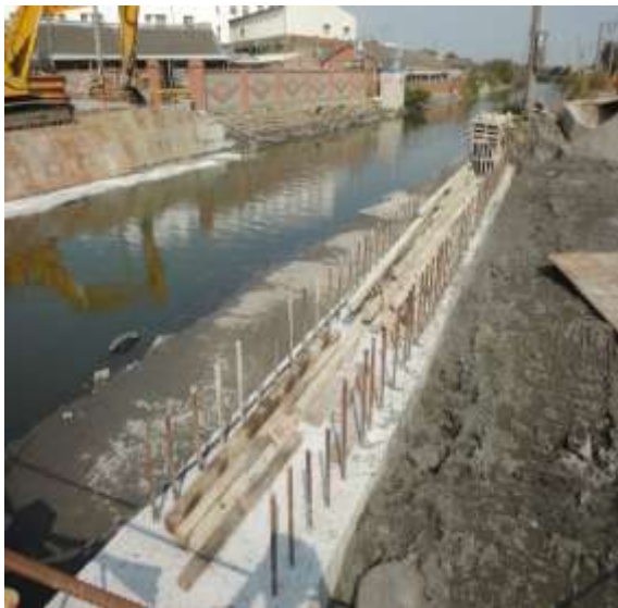
圖 3.2.2-18 大排溝渠橋梁邊墩與堤防結合 (本研究拍攝 2011.10) 圖 3.2.2-19 預力橋之橋邊墩基礎與擋土牆 (本研究拍攝 2011.07)
