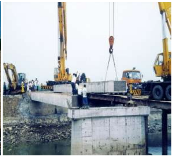
圖 3.2.1-6 密集梁現場施作與吊梁情形 (嘉邑行善團提供)
