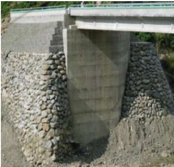
圖 4.2.2-3 新山美大橋之橋台 (本研究拍攝於 2011.12)
