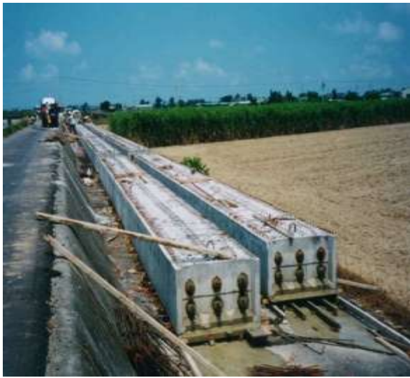
圖 3.2.1-6 密集梁現場施作與吊梁情形 (嘉邑行善團提供)
