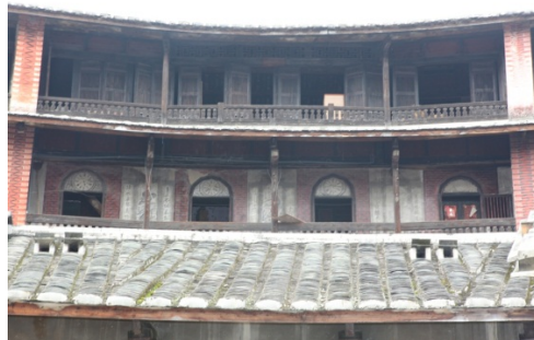
圖 4-2-2-8、主樓二、三樓及廚房屋頂
