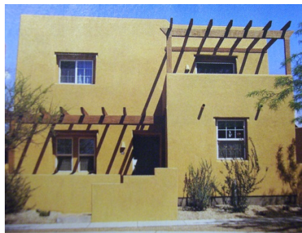
圖 3-1-2-2、泥磚(Adobe)建築
