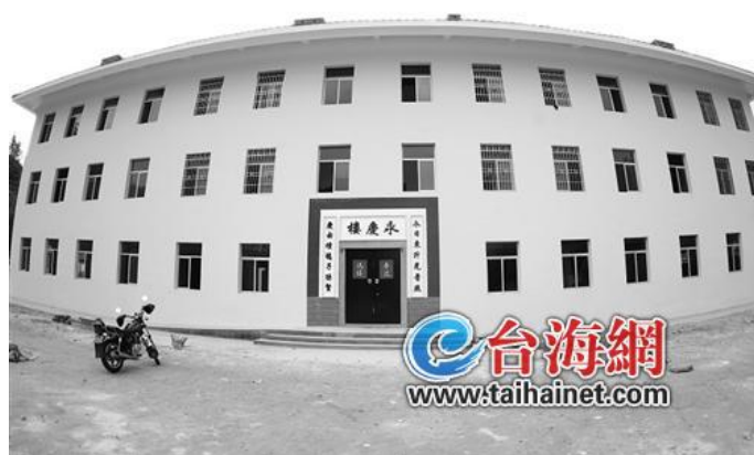
圖 4-4-1、鋼筋水泥建造的永慶樓
