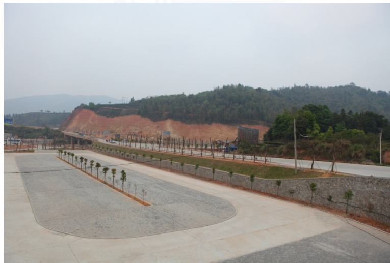
圖 6-5、永定尚未完工啟用的停車場
