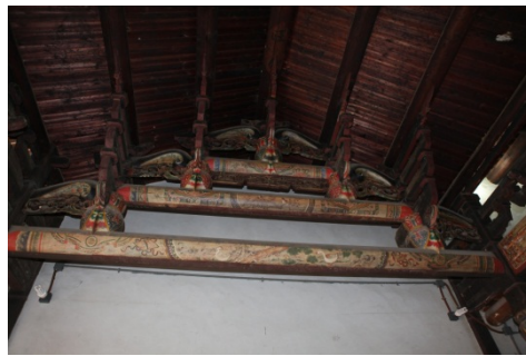
圖 4-2-2-10、梁下電線配置現況
