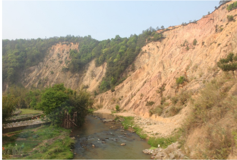
圖 6-6、邊坡崩塌現況
