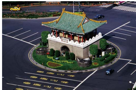
圖 5-4-2、整修後的東門
