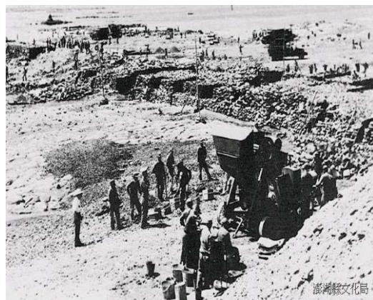
石滬被拆解做為跨海大橋建材。資料來源：澎湖縣文化局網站。（年代不詳）
