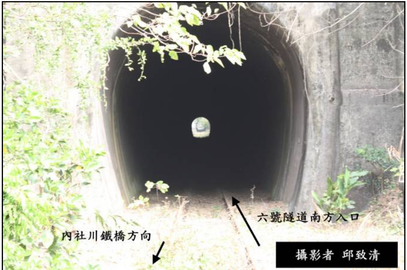
圖表 9 六號隧道入口
