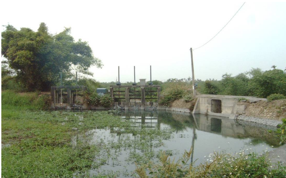
【照片 3-8】 石龜溪圳源頭攔水堰 研究者拍攝
