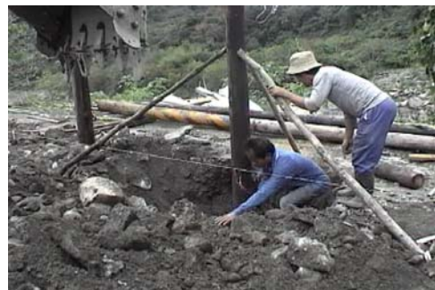
【圖 4-20】長老開始用土叉來鬆動柱子周圍的土實例〈筆者，2006.11，玉峰〉
