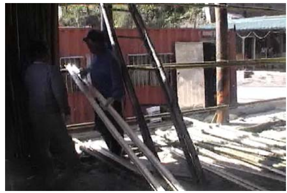
【圖 4-57】先在下面量一量大約的長度，再拿上去比〈筆者，2006.12，玉峰〉
