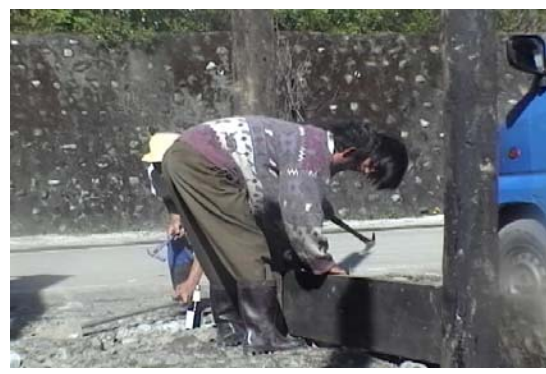
【圖 4-24】在柱子內側釘上板模實例〈筆者，2006.11，玉峰〉
