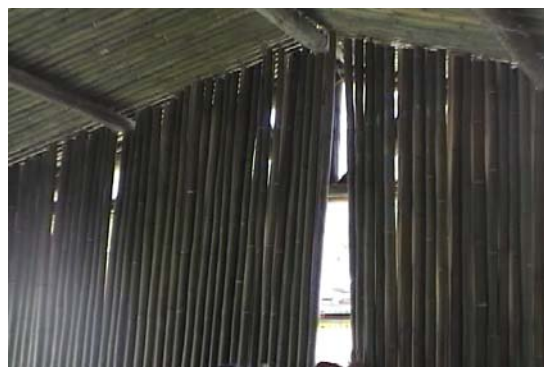
【圖 4-64】還沒排竹子的缺口，是呈現倒 V 字型實例〈筆者，2006.12，玉峰〉
