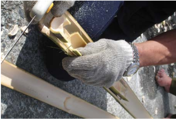
【圖 4-27】以標準竹來大量製作屋頂竹實例〈筆者，2006.12，玉峰〉
