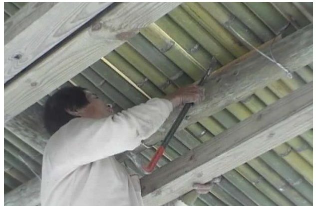
【圖 4-36】長老用工具為隙縫做的補強工作〈筆者，2006.12，玉峰〉
