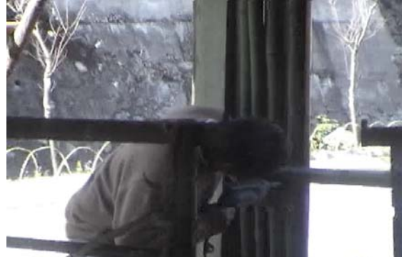
【圖 4-61】每排進幾根竹子，就要用電鑽 鑽洞，然後用鐵絲將橫竹與竹牆固定綁緊 實例〈筆者，2006.12，玉峰〉
