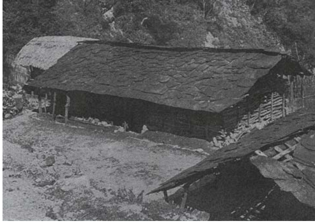
【圖 3-7】泰雅木造家屋之石板屋頂〈千千岩助太郎，1960，《台灣高砂族的住家》，台北：南天，P.21〉
