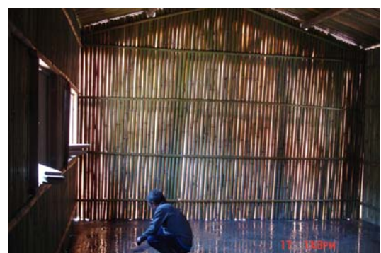
【圖 4-78】亞偉長老用抹刀慢慢抹出平坦的水泥實例〈筆者，2006.12，玉峰〉
