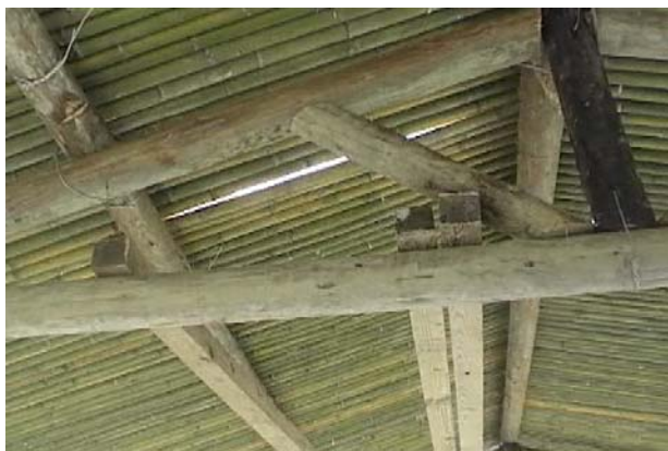
【圖 4-35】屋頂因為公母竹放置錯誤所出現的隙縫實例〈筆者，2006.12，玉峰〉
