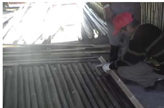
【圖 4-59】用鋸子切掉多餘的部份實例 〈筆者，2006.12，玉峰〉
