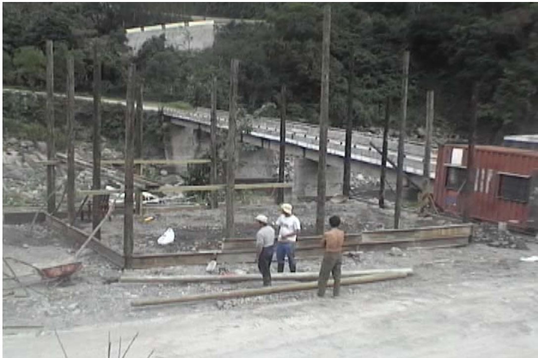
【圖 4-26】立柱完工後，在柱子之間榜上木板，好架設屋樑〈筆者， 2006.11，玉峰〉
