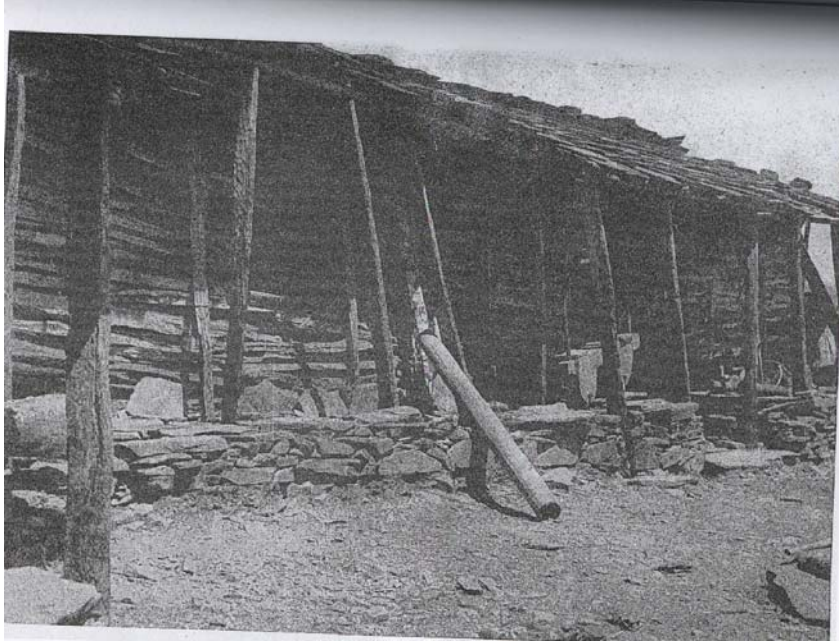
【圖 3-6】泰雅木造家屋之積木式牆壁〈千千岩助太郎，1960，《台灣高砂族的住家》，台北：南天，P.9〉
