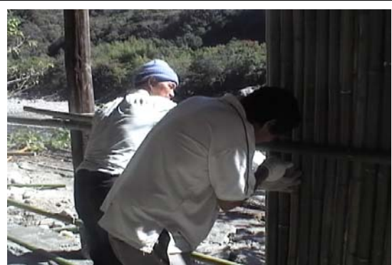
【圖 4-44】長老每七根竹子就用電鑽鑽洞，並用鐵絲將竹牆與橫竹固定實例〈筆者，2006.12，玉峰〉
