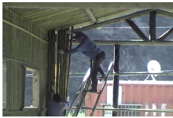
【圖 4-56】爬梯子到上面，用鋸子修竹子高度實例〈筆者，2006.12，玉峰〉
