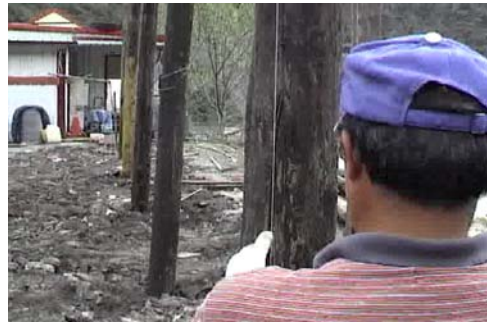
【圖 4-21】以石頭水平測量柱子是否與地面垂直實例〈筆者，2006.11，玉峰〉
