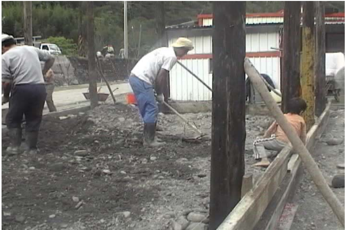
【圖 4-25】在板模內部鋪上石頭與沙子並且讓其平均，好可以鋪水泥 實例〈筆者，2006.11，玉峰〉
