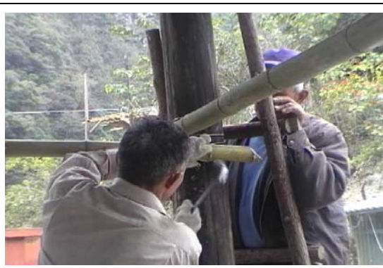
【圖 4-40】長老釘釘子在竹架下，好用來托住竹子實例〈筆者，2006.12，玉峰〉
