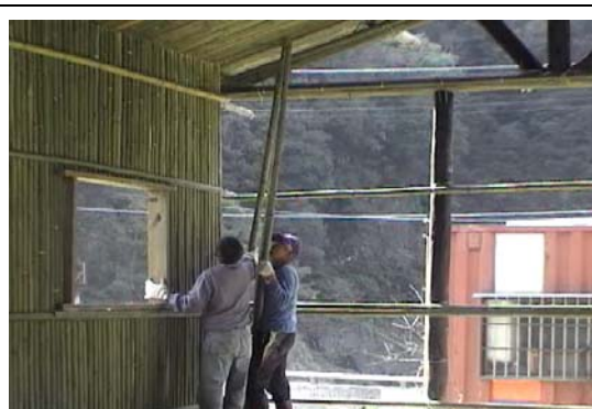
【圖 4-55】發現竹子高度不好拿捏導致最後要裝上去的竹子還是太高，排好的竹子放不進去〈筆者，2006.12，玉峰〉
