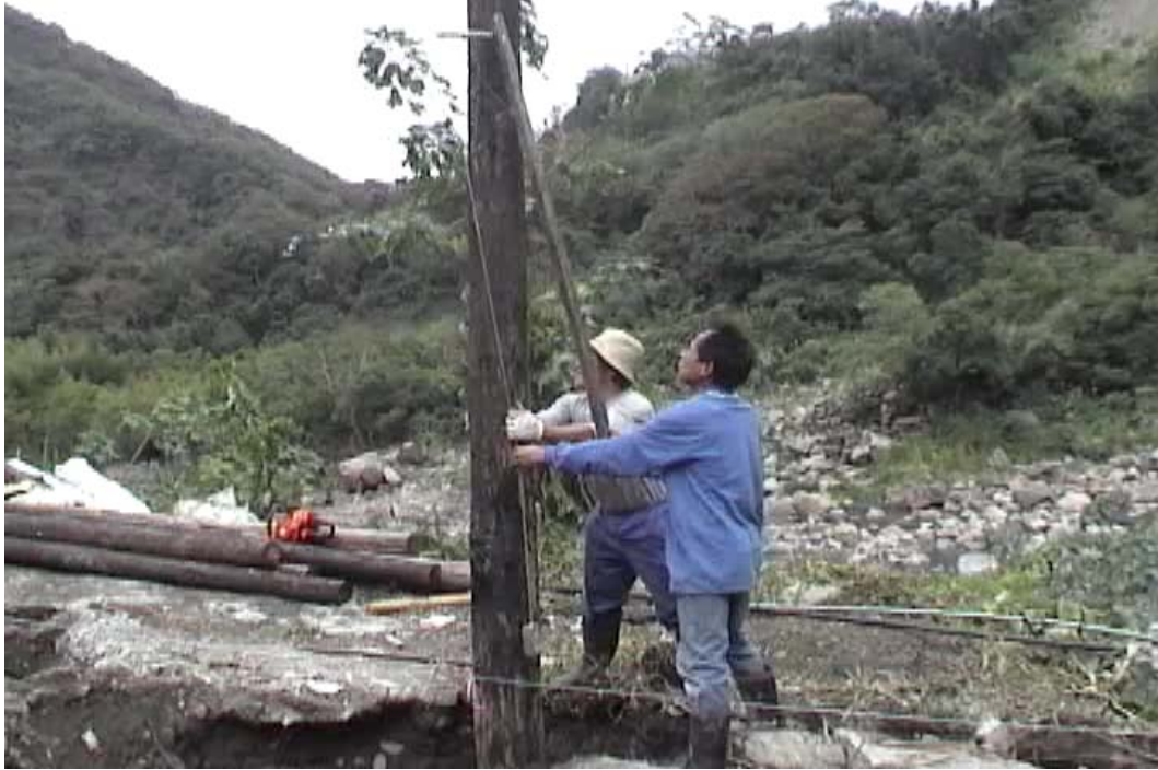
【圖 4-18】以石頭水平測量柱子是否與地面垂直實例〈筆者，2006.11，玉峰〉
