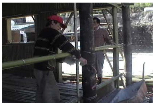
【圖 4-60】先要在山形牆中間排一根高度最長的 竹子，然後用塑膠繩把竹子和夾著竹子的橫竹綁 緊固定實例〈筆者，2006.12，玉峰〉
