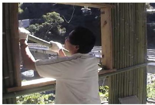
【圖 4-70】拿一根竹子斜架在窗框裡面，窗框才又變正〈筆者，2006.12，玉峰〉
