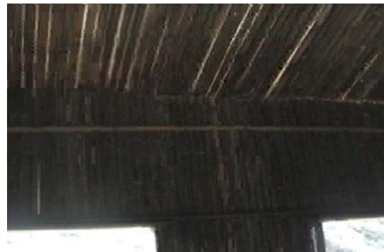
【圖 4-67】黃未吉長老還是忍不住指著竹屋前後兩邊牆面上方的橫竹放錯地方了，應該要放在竹子的最上方才行〈筆者，2006.12，玉峰〉
