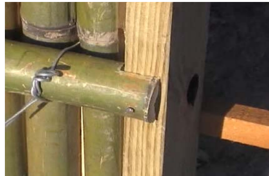
【圖 4-73】用鐵釘將橫竹與門框釘緊實例〈筆者，2006.12，玉峰〉
