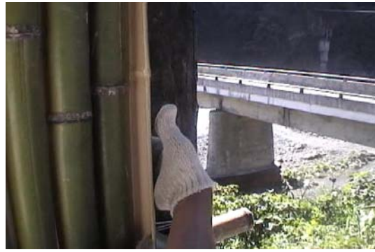
【圖 4-47】長老指出轉角處竹子的竹面一定要夠寬大，才能包住整個轉角避免漏雨 實例〈筆者，2006.12，玉峰〉
