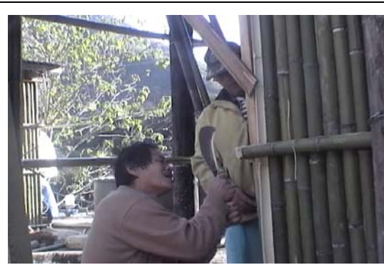
【圖 4-74】中間的橫竹也是和下面橫竹一樣的固定法實例〈筆者，2006.12，玉峰〉
