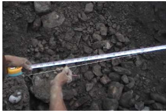
【圖 4-23】用尺定好長度並且標示立柱之處實例〈筆者，2006.11，玉峰〉
