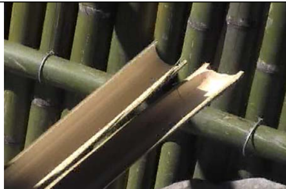
【圖 4-49】將已經量好的長度從記號之處重疊，一直到想要的長度時候，再用鋸子做個記號。〈筆者，2006.12，玉峰〉
