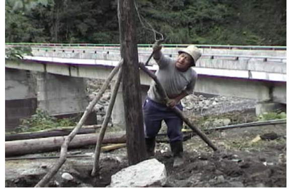
【圖 4-22】長老拔除支撐木實例〈筆者，2006.11，玉峰〉
