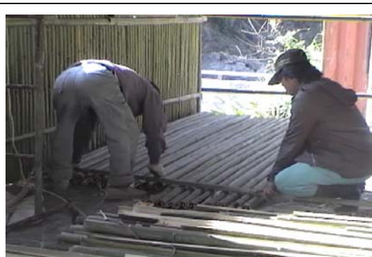
【圖 4-54】先把整面牆的竹子，先在地面排好實例〈筆者，2006.12，玉峰〉
