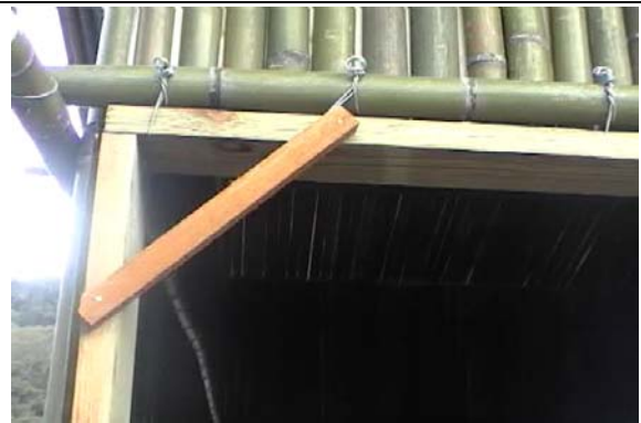
【圖 4-71】窗框的兩個直角上已經釘上斜角，來增加結構的穩固實例〈筆者，2006.12，玉峰〉
