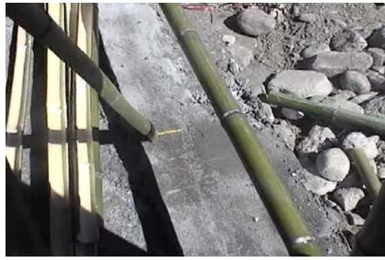
【圖 4-68】長老會在排竹牆的水泥上先畫上黃色的粉筆，代表窗戶的位置實例〈筆者，2006.12，玉峰〉
