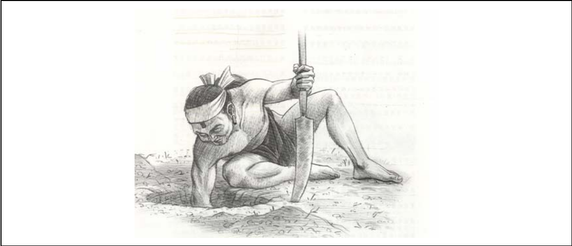
【圖 3-20】挖掘立柱坑圖〈林為道，2003，《泰雅傳統竹屋》，P.85〉
