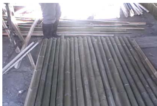
【圖 4-58】先量山形牆最低和最高的 高度，然後在地面上的竹子做下記號〈筆 者，2006.12，玉峰〉
