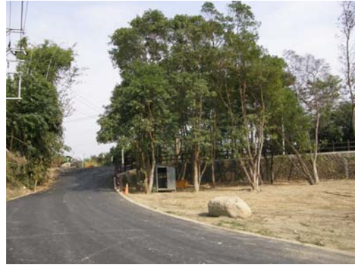
於主要道路以建造車輛緩坡道
