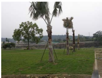
棕櫚樹之固樁，深度不足，缺軟質護墊 圖 4-14 現地之移植作業
