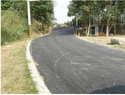
主要通行車道以柏油鋪設
