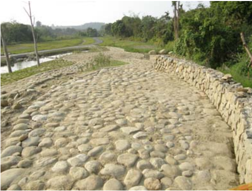
人行步道全部以石塊加表土鋪設
