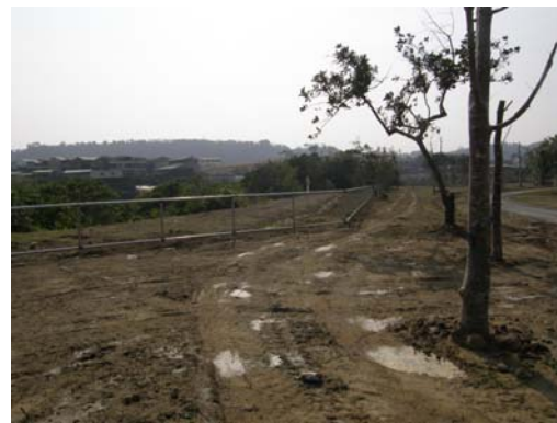
以鋁製圍籬區隔河堤
