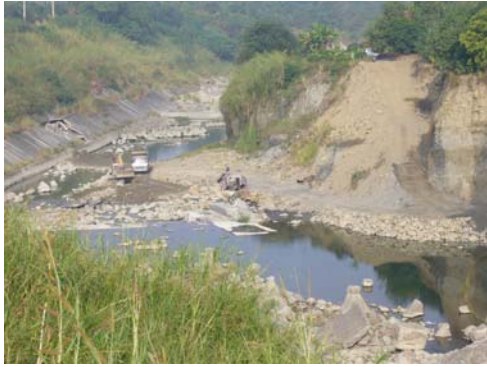
工程車輛於河道中建築便道
