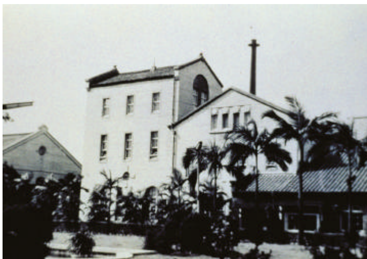
圖 3-2-2 未遷廠前的前台北酒廠局部建物，拍照年代不詳（資料來源：藝術文化環境改造協會提供）
