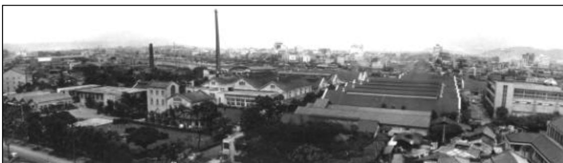
圖 3-2-3 未遷廠前的前台北酒廠全區照，拍照年代不詳（資料來源：藝術文化環境改造協會提供）
