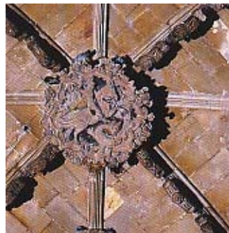
圖 4-50 (位於迴廊噴泉的正上方)
