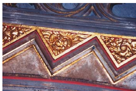
圖 4-65 (佈道壇的樓梯側邊)
