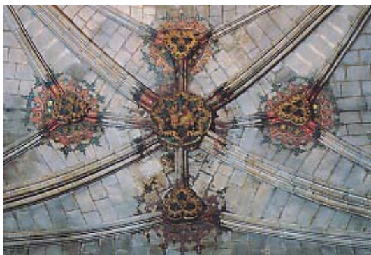
圖 4-29 (位於迴廊進入中殿的上方)
