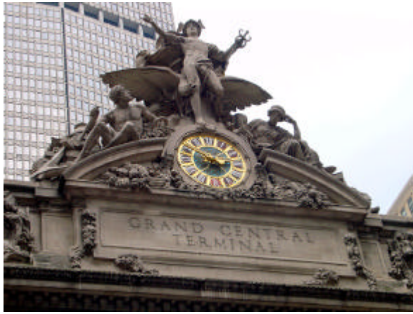
照片 3.5 紐約車站
