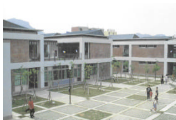
照片 4-38 教室前合院 資料來源：『大破大立：遠東 921 校園建築獎』田園城市文化事業有限公司 2003.12
