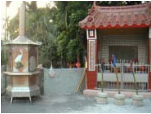
圖 4-7 重建的北營外觀，楹聯寫道： 將帥顯赫安萬慶 軍兵靈感護千家
