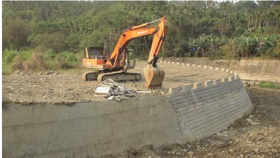
圖 4-51：水泥護岸桃仔寮-崎頭段 資料來源：本研究拍攝
