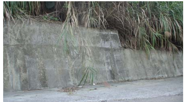
圖 4-49：水泥擋土牆 2 資料來源：本研究拍攝
