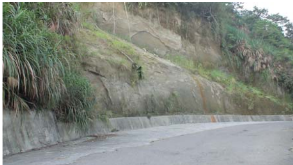
圖 4-48：水泥擋土牆 1 資料來源：本研究拍攝
