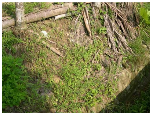
圖 5-6：農路內側邊坡植生 資料來源：本研究 2004 年攝
