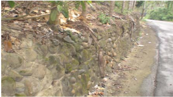
圖 4-46：水泥加石砌坡坎 資料來源：本研究拍攝
