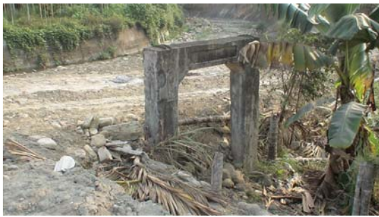
圖 4-21：廢棄吊橋的遺跡 資料來源：本研究 2007 攝
