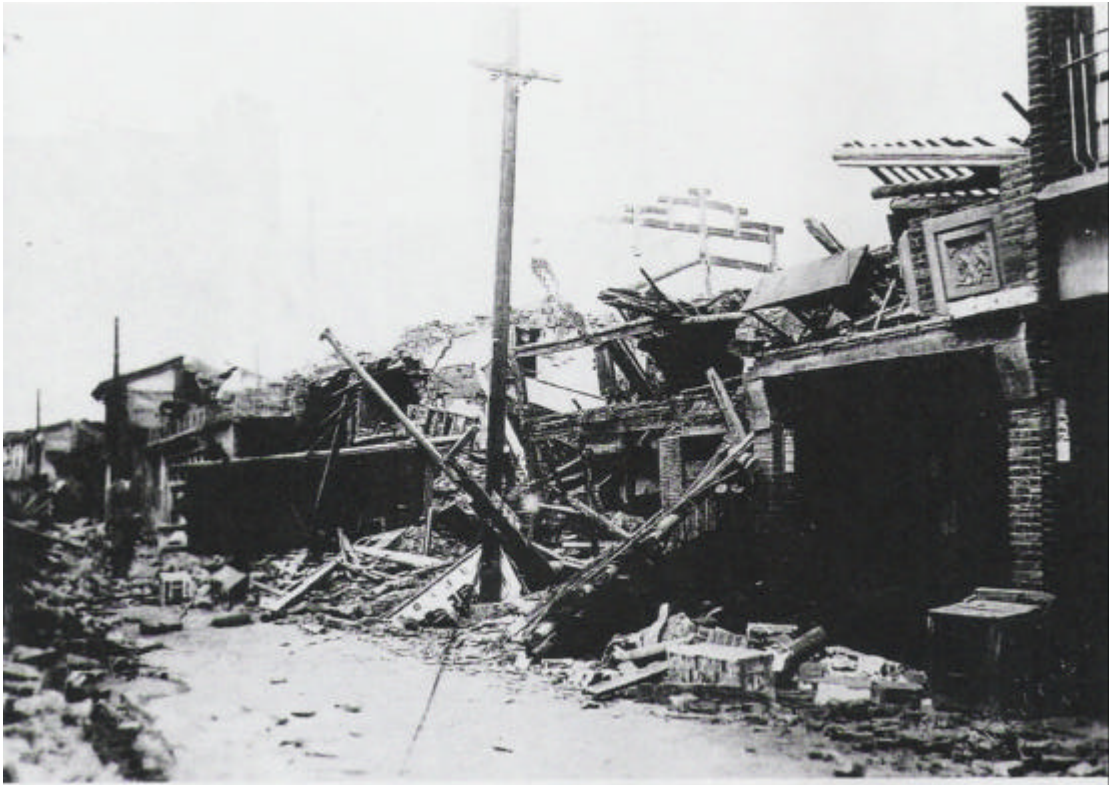
圖 5 - 5 日本昭和十年(1935 年)墩仔腳大地震,清水蘭鈴街(今文昌街)房屋倒塌斷垣殘壁之景象
