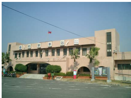
【圖 2-1-2】枋寮火車站現況圖 資料來源：本研究拍攝
