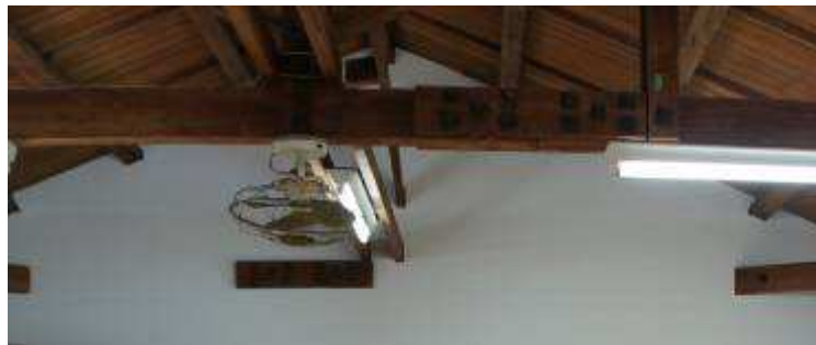
圖 4.29 山美天主堂內部後半段屋頂以木架構造
