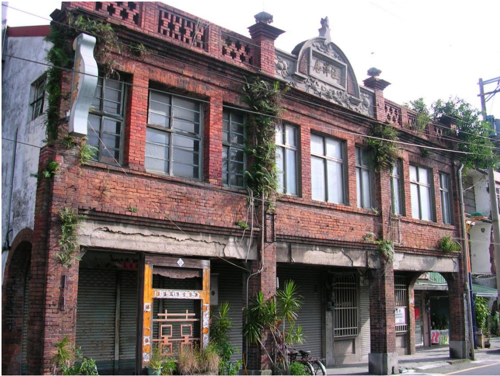
圖 1-3 鶯歌舊建築「汪洋居」
