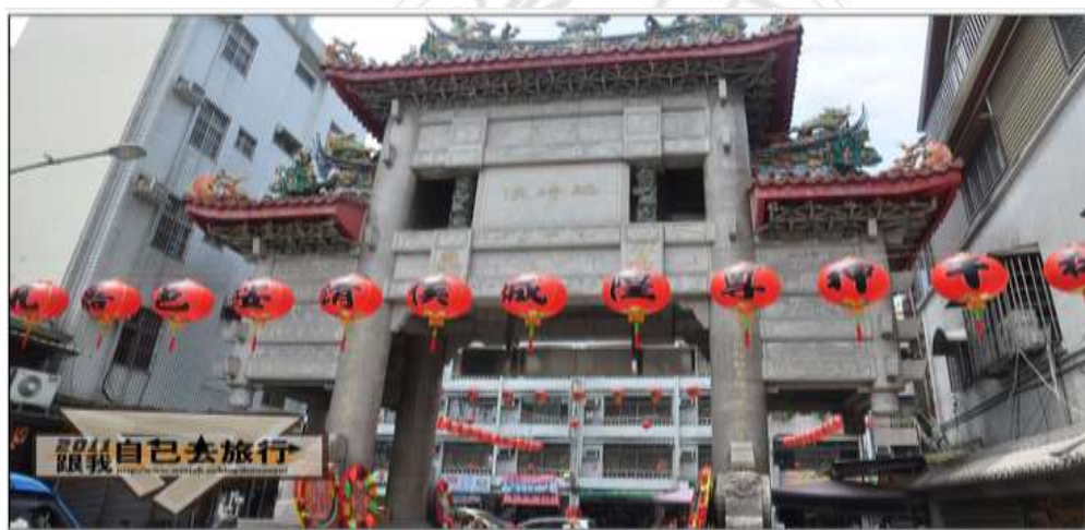
嘉義城隍廟的牌樓採用四柱三間三重樓之設計
