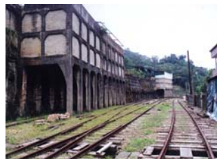
■礦區之卸煤區
